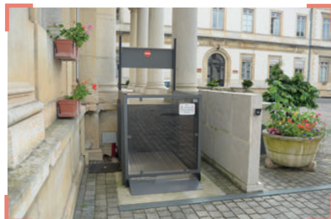
Mise en accessibilité des salons de la préfecture et du Conseil départemental
