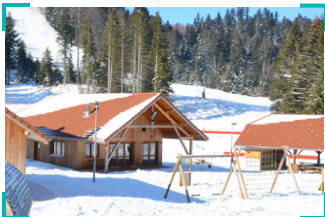
Bâtiment d'accueil du public - station de ski alpin à Hauteville-Lompnes - DETR : 26 073 €
