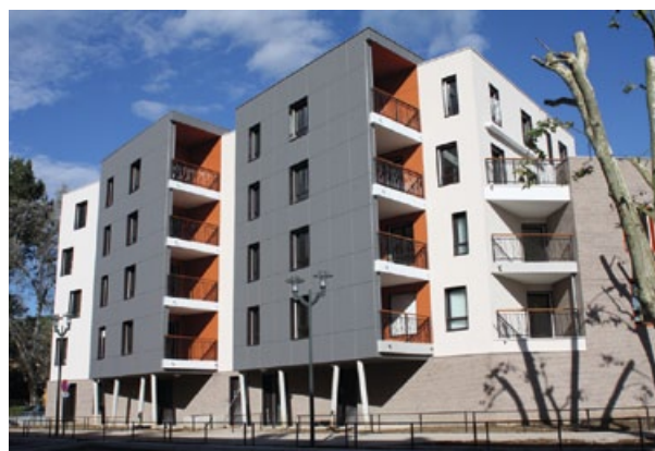
Rénovation urbaine à Bourg-en-Bresse
