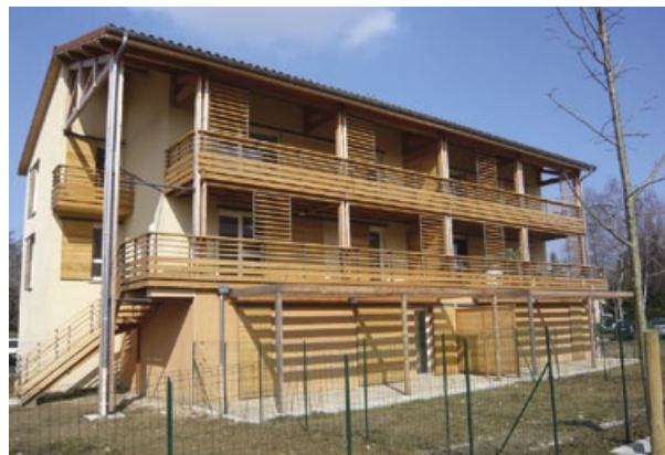
12 logements collectifs «bâtiment basse consommation» à Montrevel-en-Bresse
