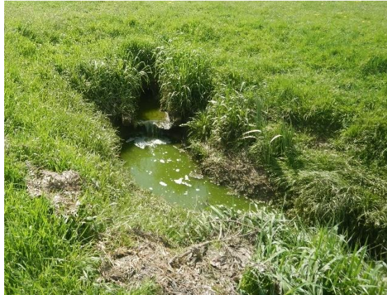
Figure 56 : Rejet de la STEP
