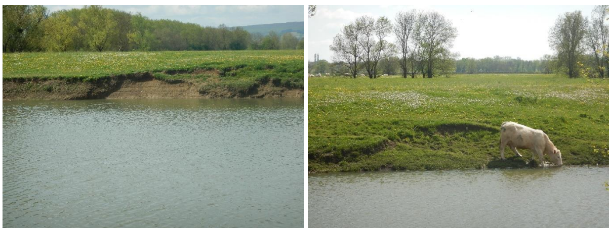
Figure 43 : Erosions de berges
