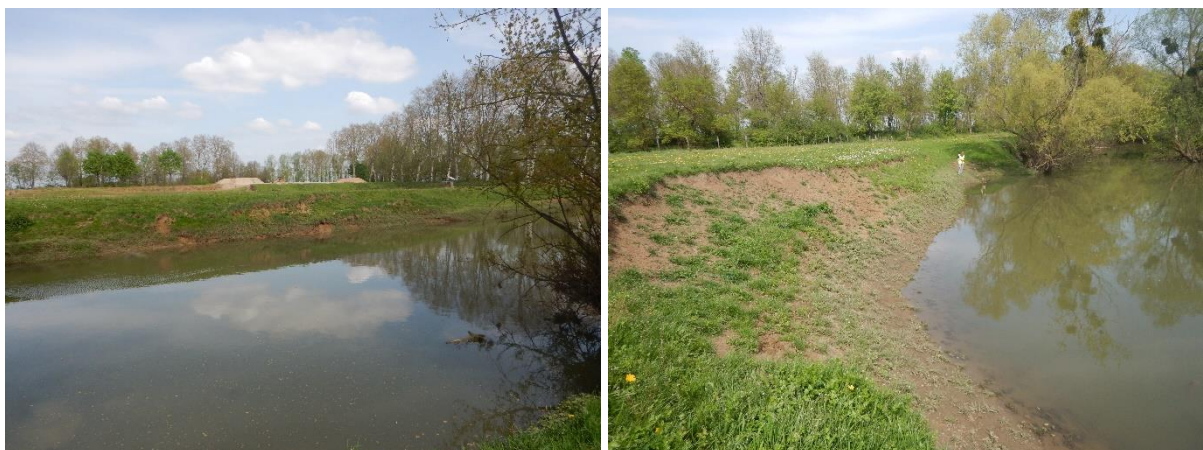
Figure 42 : Anses d'érosion sur la partie aval
