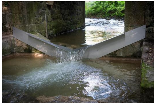
Exemple de barrière physique pouvant être installée au droit d'un ouvrage
