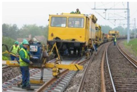
*Longs Rails soudés sur traverses béton*
