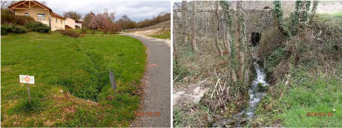
Figure 33: Axe en amont du busage (à gauche) - Axe à nouveau à ciel ouvert à l'aval du lavoir
