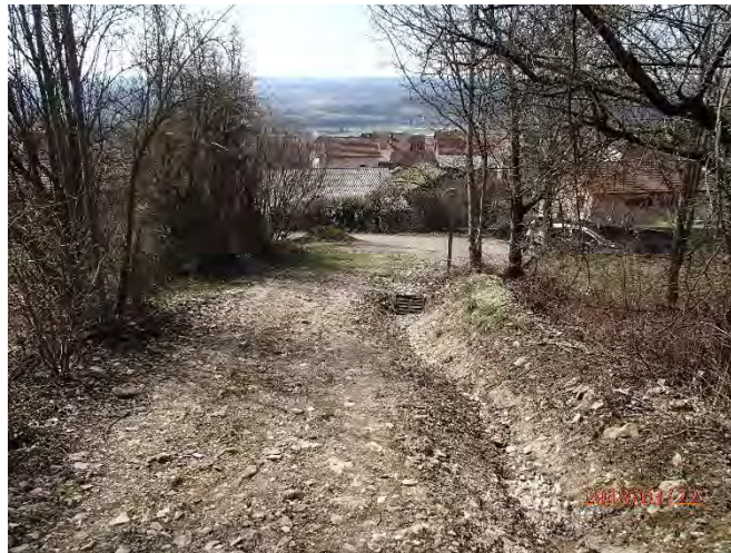
Figure 30 : Risque d'obstruction d'une grille en amont immédiat du chef-lieu
