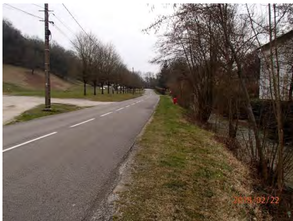
Figure 17 : Partie amont de la traversée
