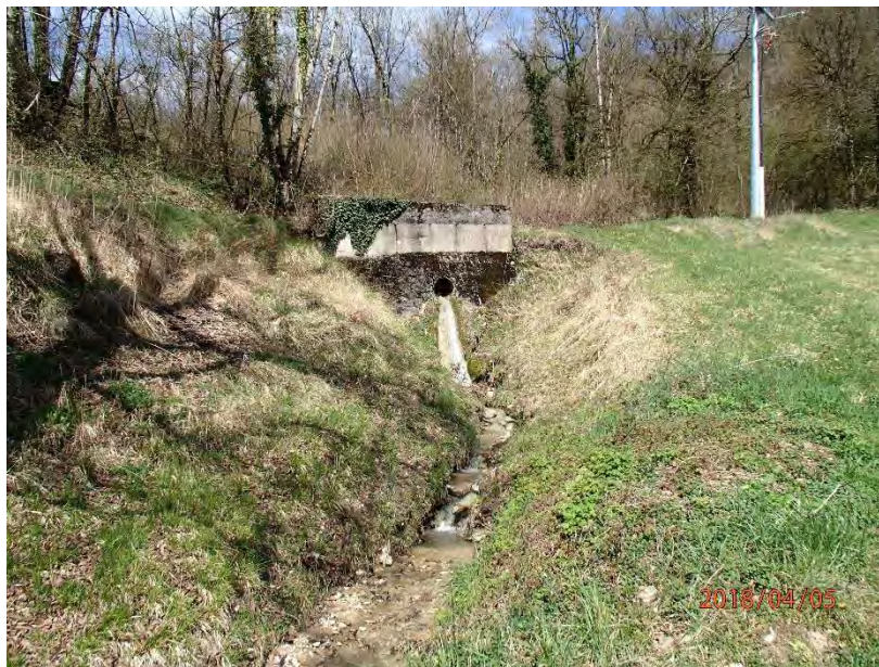
Figure 49 : Franchissement d'une piste en amont des Granges
