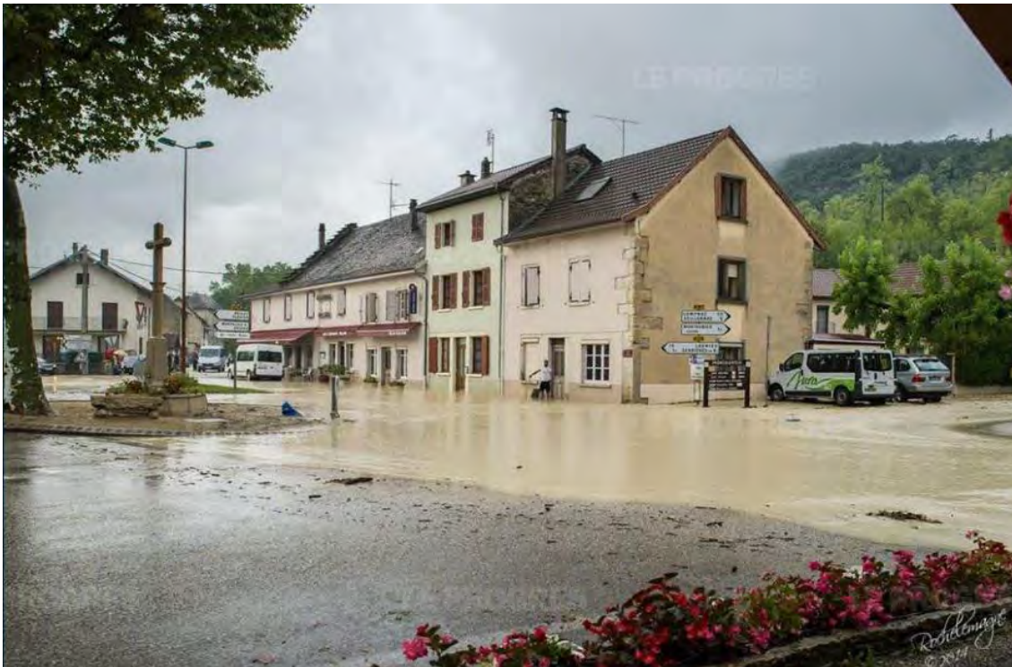
Figure 53 : cliché de l'inondation de juillet 2014 (source : Le Progrès)
