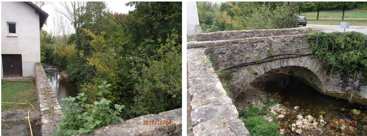
Figure 16 : premier ouvrage de franchissement dans la traversée du hameau des Granges
