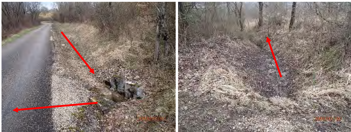
Figure 42 : Cunette et exemple de rejet dans sur le versant alimentant la ravine
