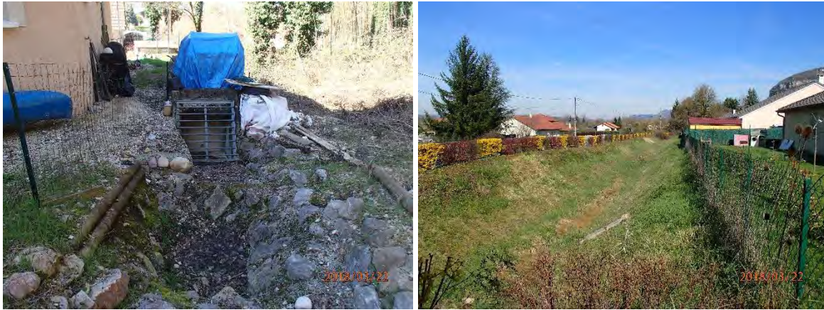
Figure 44 : Axe de déviation busé de derrière une propriété du lotissement jusqu'à un fossé en bord de route départementale
