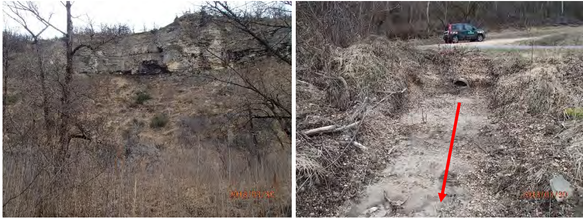
Figure 48 : Résurgences sur niche d'arrachement et rejets sur le versant alimentant la ravine Sud
