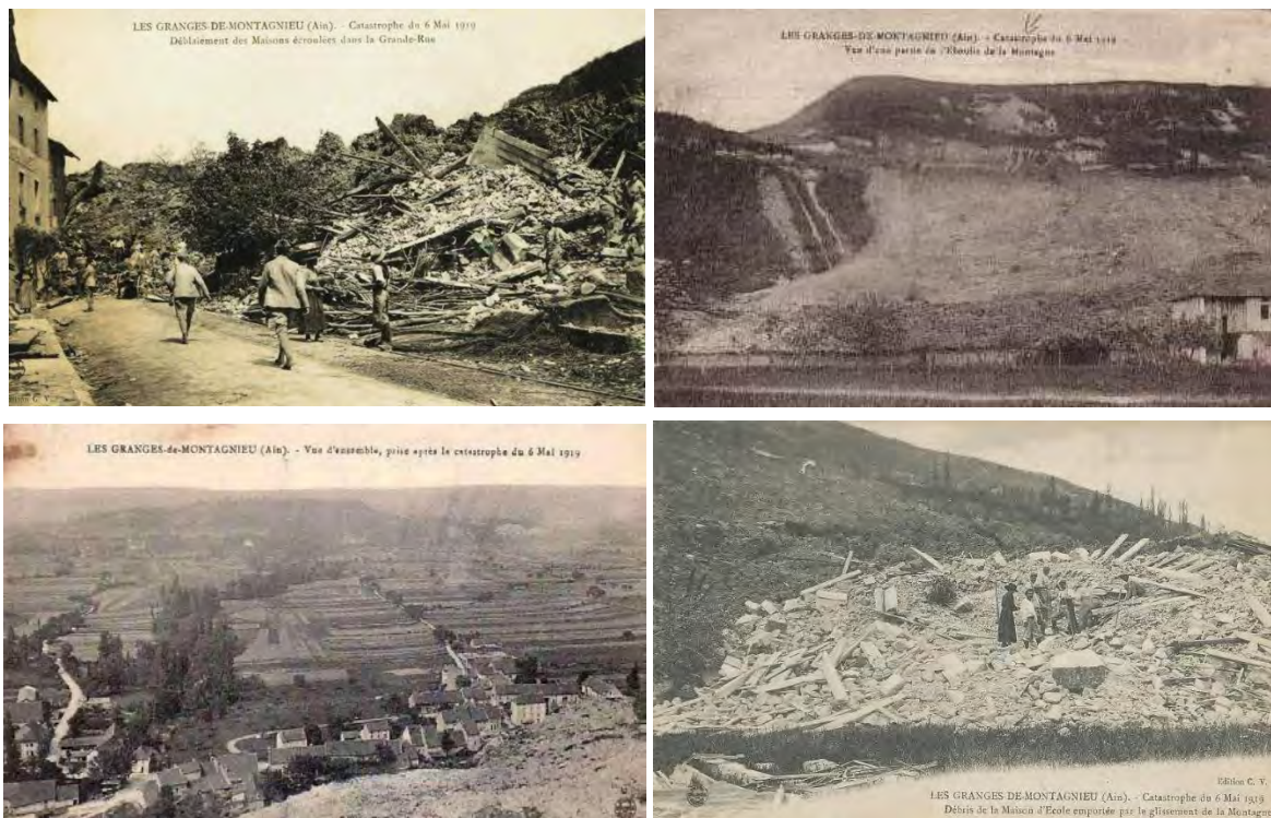
Figure 8 : clichés du glissement de 1919 (cartes postales anciennes, source : web)
