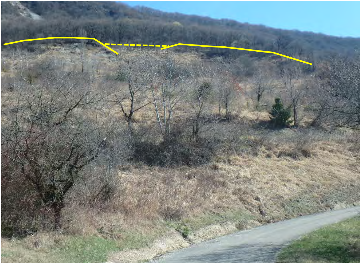
Figure 11 : Zone en glissement actif en amont de la route de Seyssel
