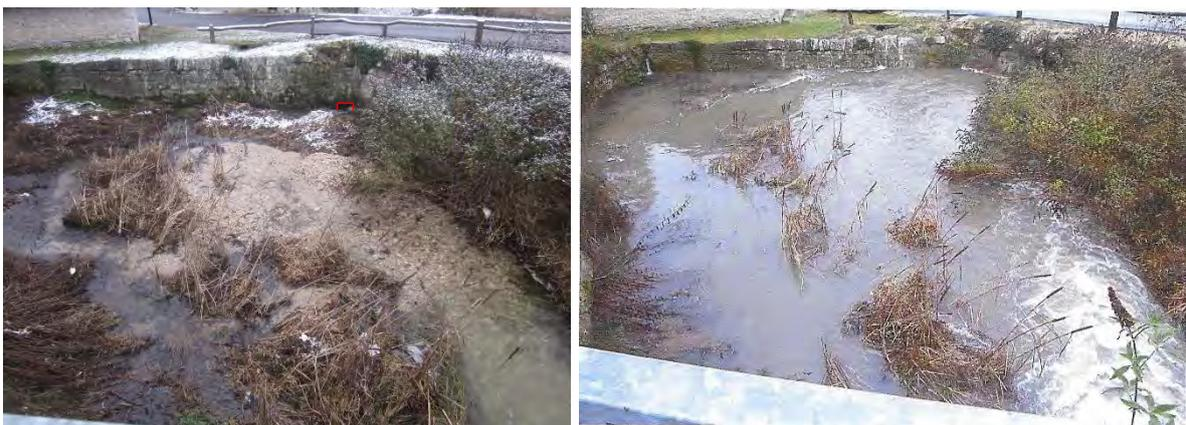
Figure 46 : Ecluse engravée et rétention d'eau due à une capacité d'évacuation devenue insuffisante (source : commune de Lhuis)
