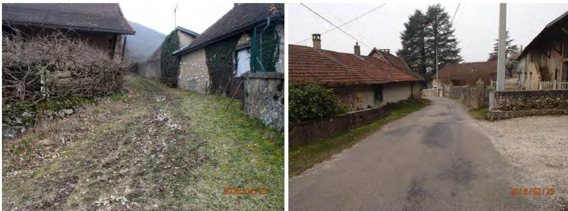
Figure 76 : Traces d'un ruissellement récent au début du chemin et voirie suivi par les écoulements
