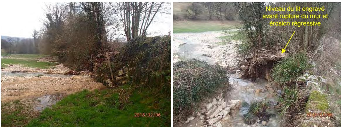
Figure 37 : Rupture du mur en rive gauche d'un ancien canal et divagations dans les champs
