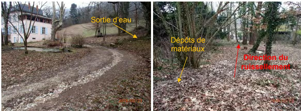
Figure 78 : Sortie d'eau et traces de ravinement sur la piste (à gauche) - écoulement possible vers la voie publique (à droite)
