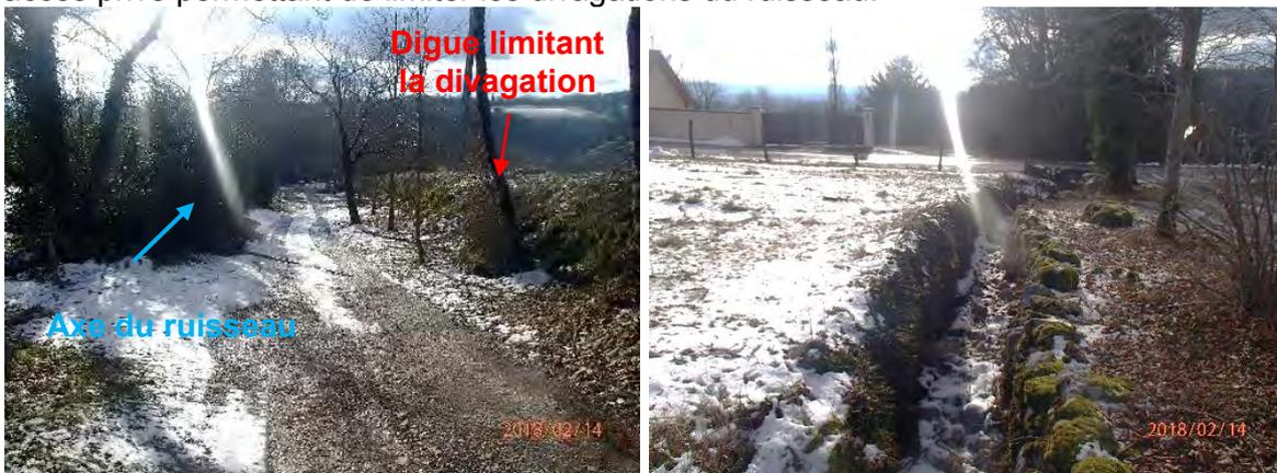
Figure 24 : Digue à droite d'une piste d'accès à une propriété (à gauche) – canal empierré à l'approche de la route communale (à droite)
