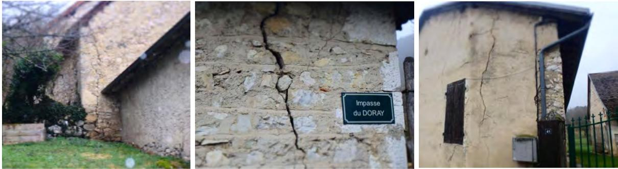
Figure 13 : de gauche à droite, maison fissurée à St Martin, maisons fissurées à Lhuis
