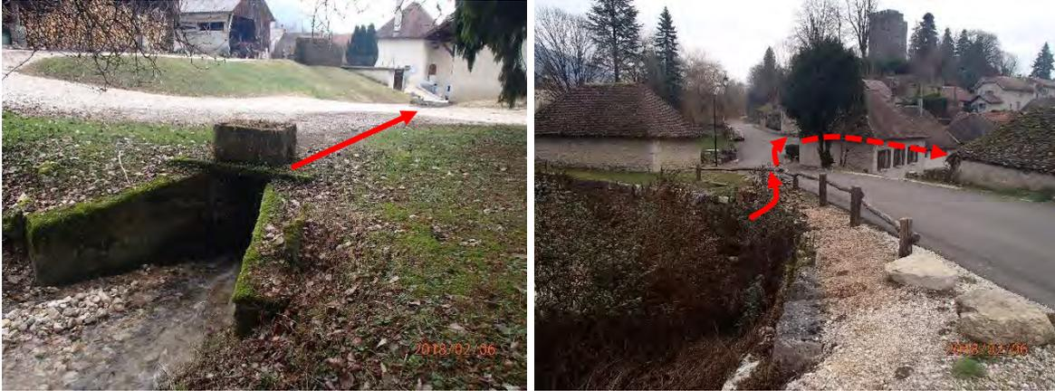
Figure 47 : Direction suivie par les débordements après obstruction des ouvrages
