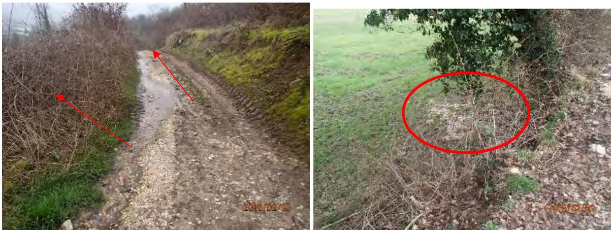
Figure 30 : Axe de ruissellement vers l'Est et indice de ravinement de la piste au débouché dans la plaine
