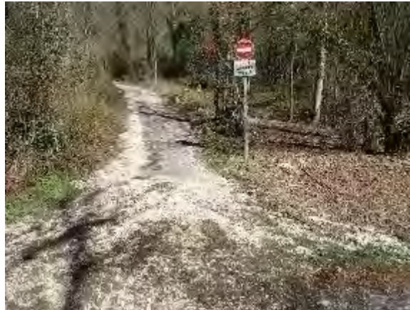
Figure 51 : Piste dans le sens de la pente, ravinée par des écoulements de surface
