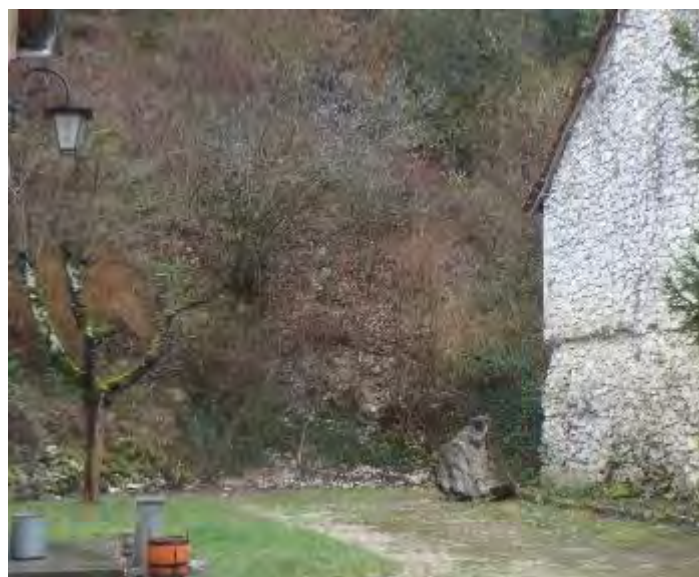
Figure 9 : bloc d'environ 2 m 3 éboulé (relativement ancien)
