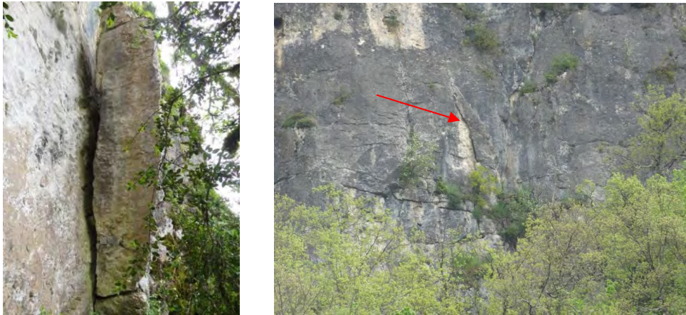
Figure 7 : Pilier de 3 à 5 m 3 à gauche, écaille de 1 à 2 m 3 à droite
