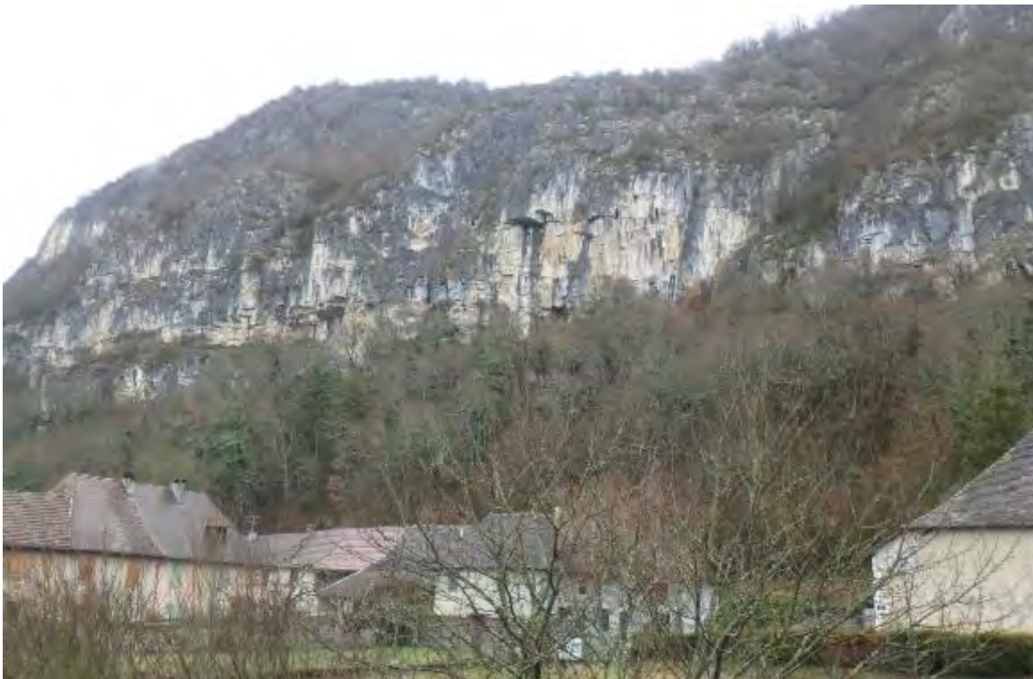
Figure 6 : vue d'ensemble de la falaise dominant Petit-Glandieu
