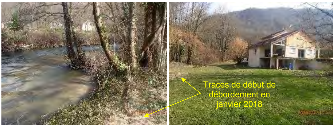
Figure 26 : Habitation pouvant être approchée par les divagations du ruisseau
