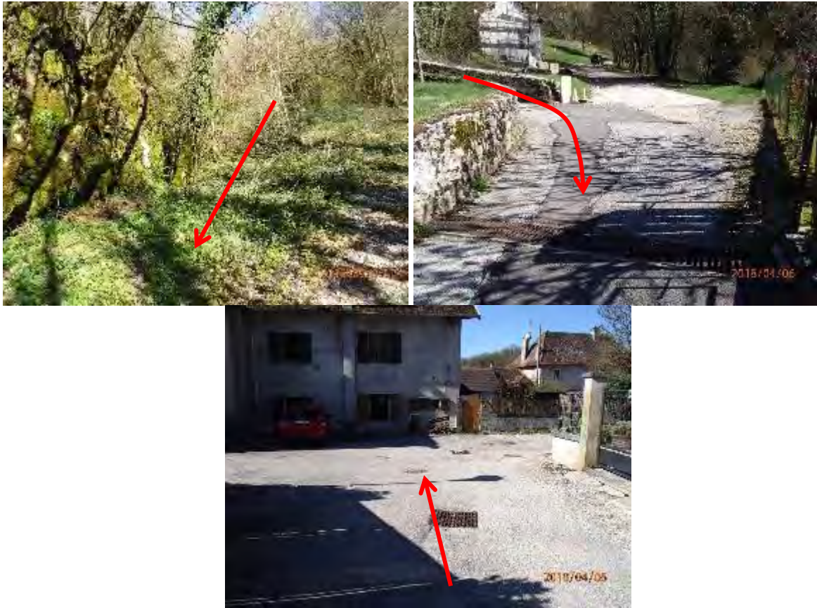
Figure 47 : Premier axe de ruissellement jusqu'au chemin du Mont
