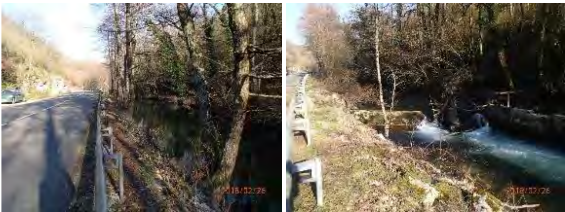
Figure 24 : Ruisseau du Gland le long de la RD10, en amont de la cascade
