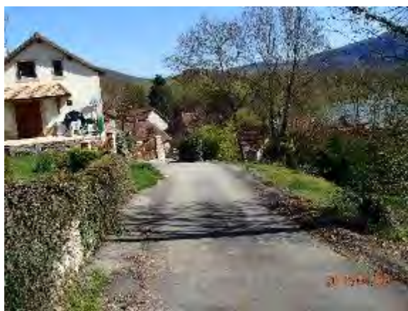
Figure 56 : Bourrelet de goudron permettant de guider la lame d'eau ruisselée
