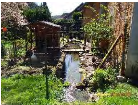
Figure 53 : Axe d'écoulement passant chez les particuliers
