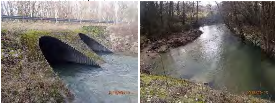
Figure 27 : Traversée de la RD19 et lit à l'aval
