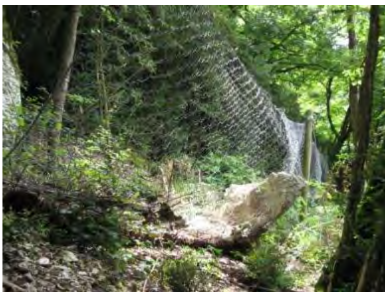
Figure 15 : filet EC1 impacté par un bloc de 150 l
