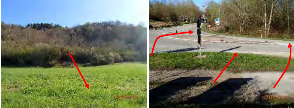
Figure 45 : Combe à l'amont du carrefour et direction des ruissellements atteignant le carrefour
