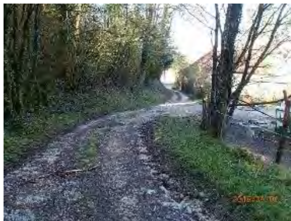
Figure 44 : Piste ravinée par l'érosion et maison susceptible d'être atteinte au second plan
