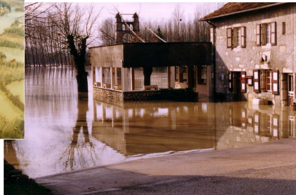
Pont de Groslée – crue de 1990 (CNR)
