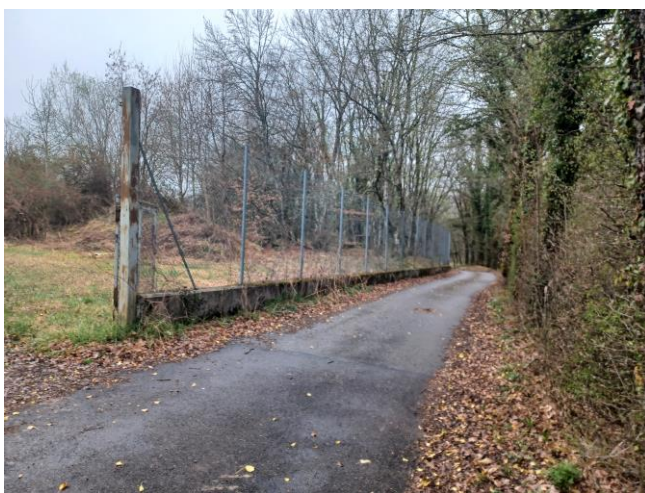
Entrée de la plateforme
