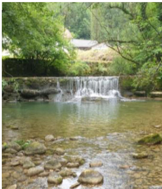
Figure 6 Sortie de la fosse qui pourrait faire l'objet d'une stabilisation afin d'assurer un niveau stable en entrée de rampe
