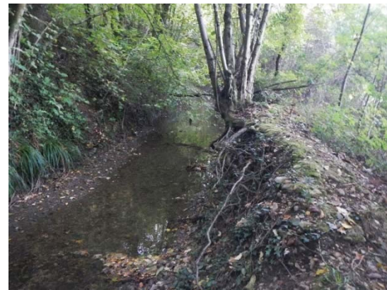
Berge rive gauche non protégée et érodée
