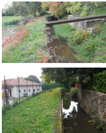
Berge protégée par des palplanches ou murs
