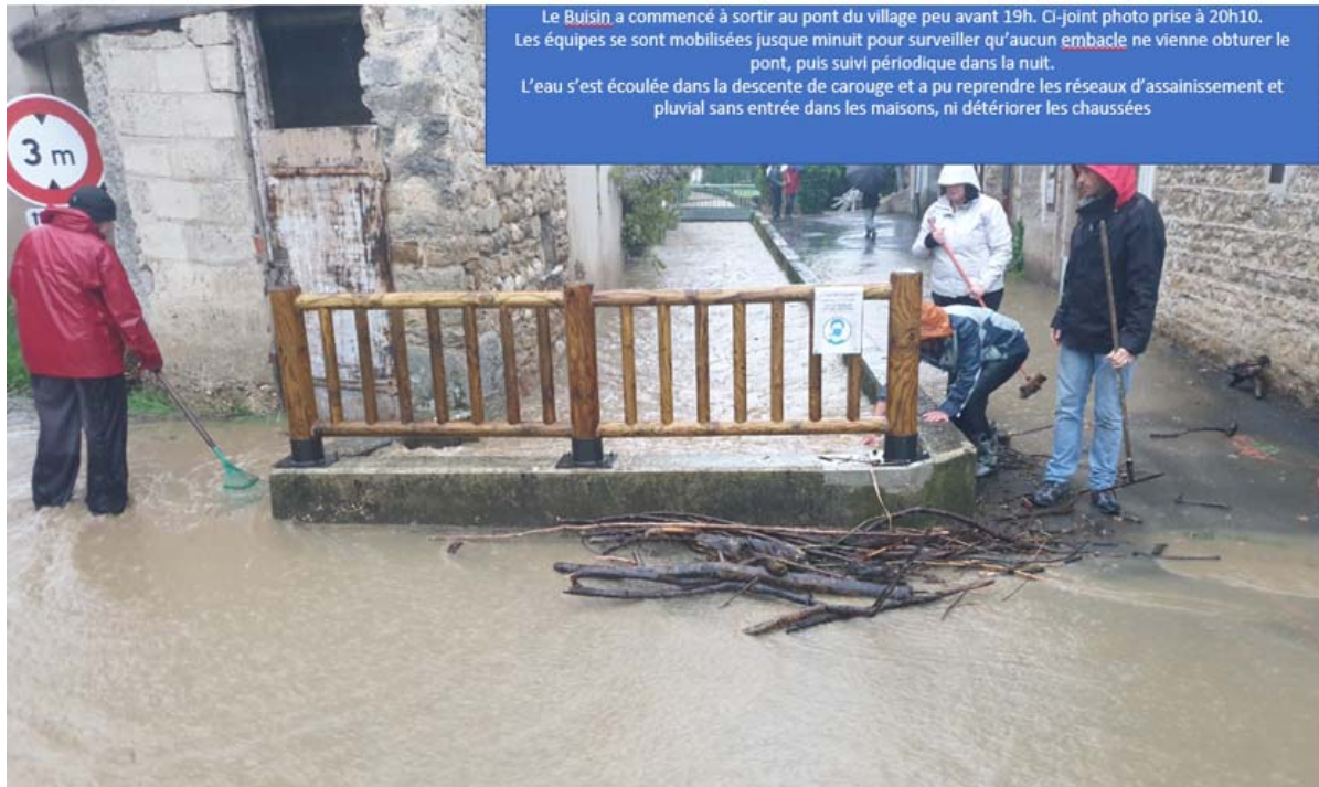
Figure 5 - Débordement au pont au centre d'Ambutrix
