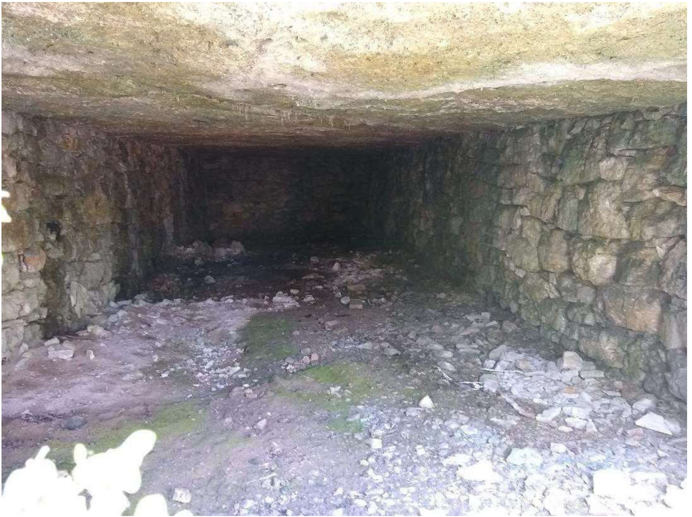
Orifice n° 10 – Photos du 30/03/2021
