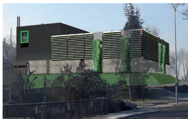
Chaufferie bois d'Oyonnax
