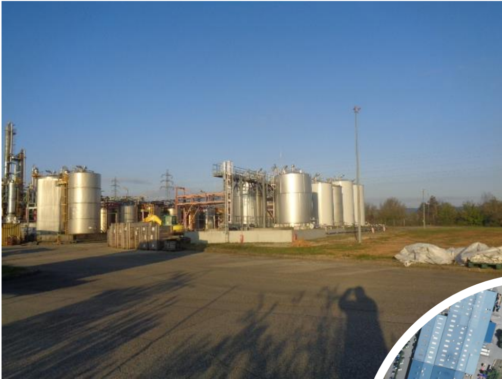
Prise de vue 3 Environnement proche avant implantation du projet
