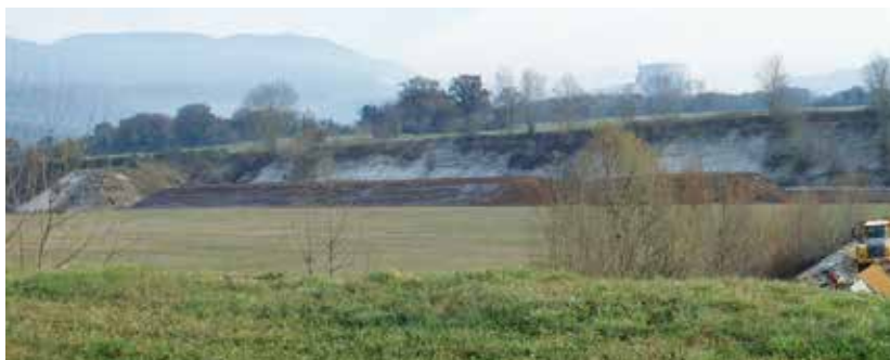
Stock de terre végétale en forme trapézoïdale
