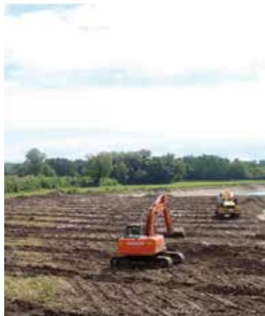
Mise en place d'un réseau de drainage artificiel
