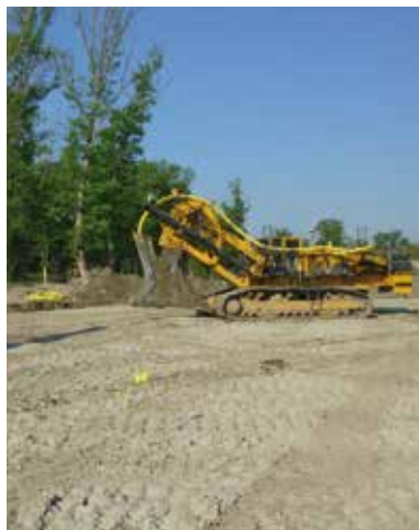
Installation des drains avec une sous-soleuse
