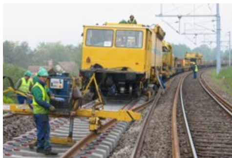
Longs Rails soudés sur traverses béton
