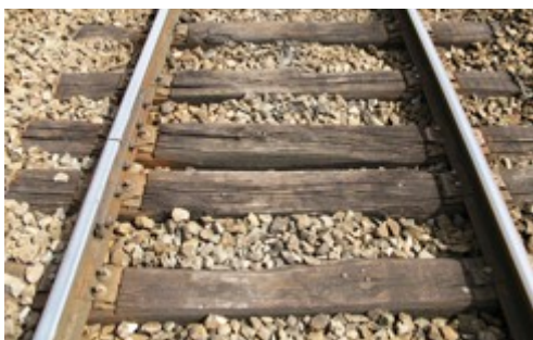
Rails courts sur traverses bois
