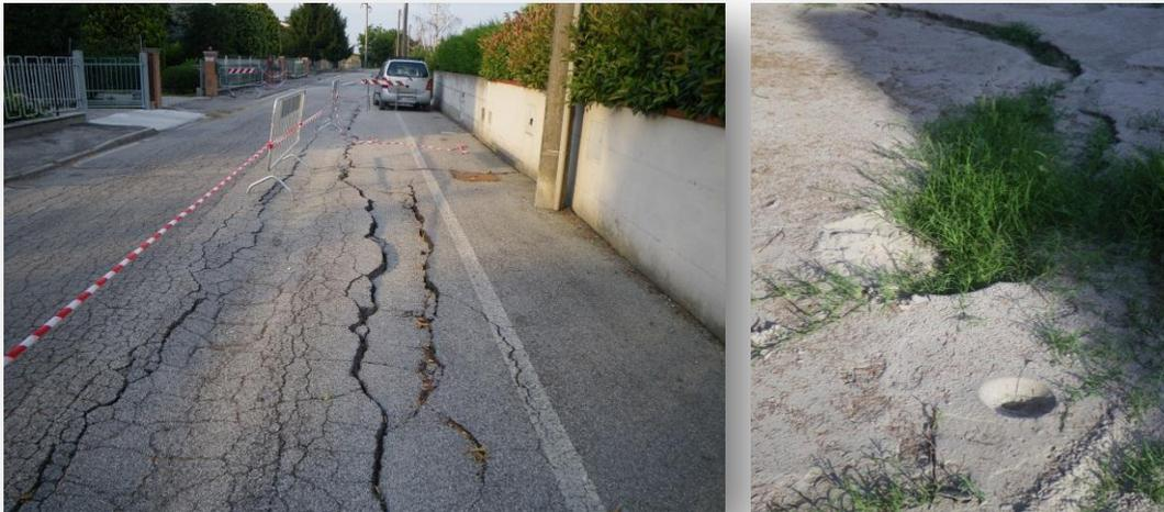
**Fissuration de la route due au phénomène de liquéfaction des sols et remontée de sable en surface avec volcan de sable (Source : BRGM)**
