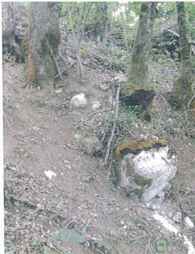
boule rocheuse déchaussée d'environ 400 kg
