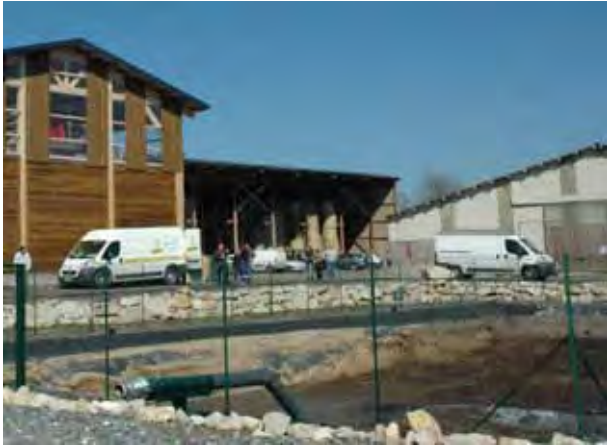
Exploitation dont la modernisation a été accompagnée par l'État et le FEADER : grange de séchage des fourrages à l'énergie solaire et fosse à lisier tapissée d'une géomembrane.
