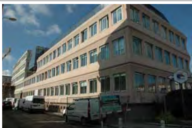
Site de La Grenouillère à Bourg-en-Bresse
