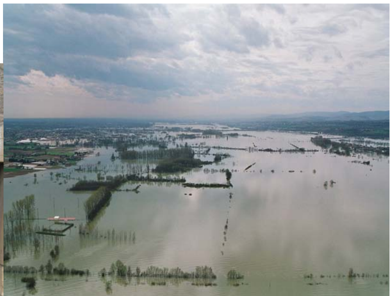
▲ Manziat Crue de 2001 (crue d'occurrence vingtennale, c'est à dire qui a une probabilité de 1/20 de se produire chaque année)
