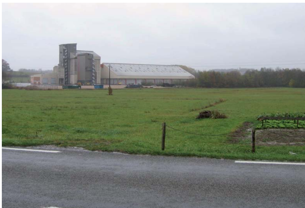
4 – Usine récemment construite dans une zone d'expansion du Sevron à Cormoz
