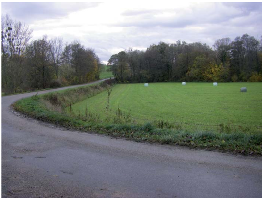
2 – Remblai d'infrastructure pouvant faire obstacle aux écoulements du Sevron en amont de Saint-Etienne-du-Bois
