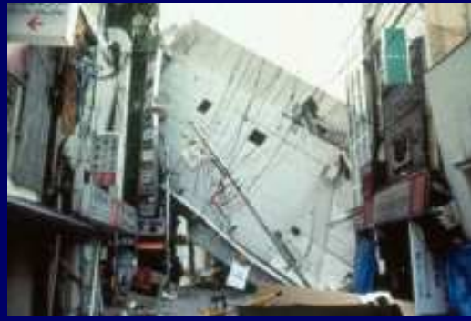
Séisme de Kobé, Japon 1995
