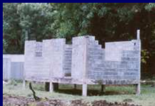
Maison en construction en zone de forte sismicité
