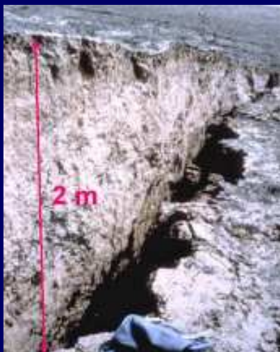
Rejet vertical Séisme d'El Asnam 1980
