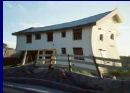
Pendant le séisme
