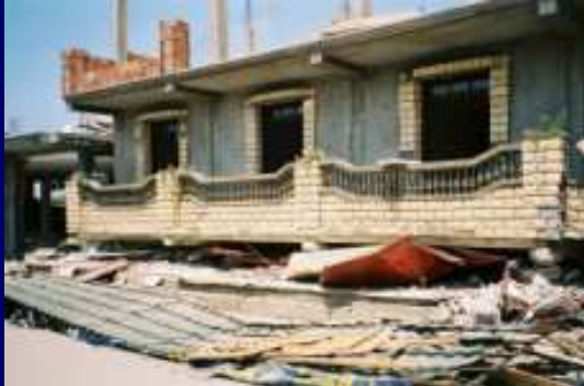
Séisme de Boumerdès, Algérie 2003
