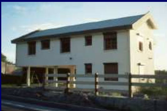
Avant le séisme
