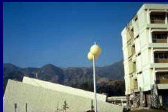
Séisme de San Fernando Californie, 1971
