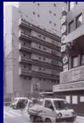
Mur armé, faibles dommages Kobé, Japon 1995
