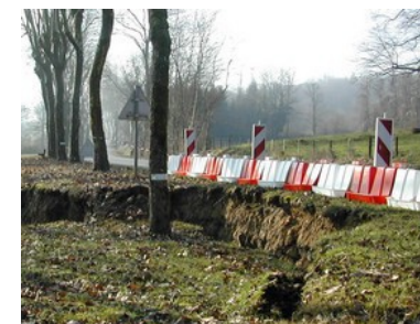
Glissement de terrain - RD 984
