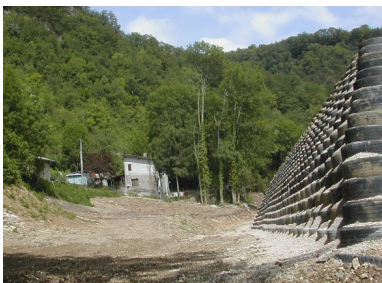
Merlon de protection - Saint Rambert
