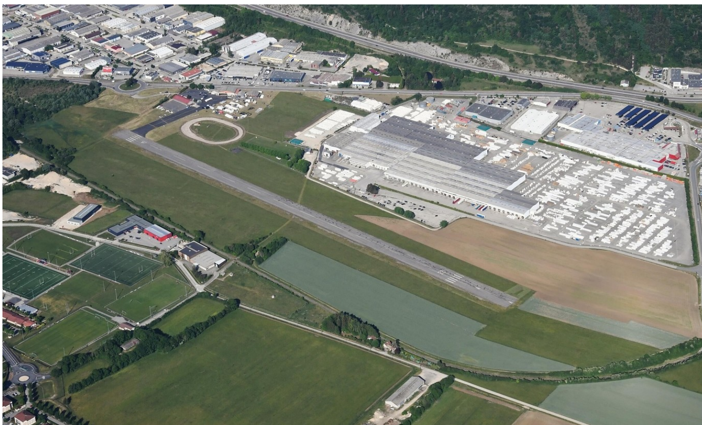
Parc industrielle Nord et ZC Les Arbents (Arbent / Oyonnax)
