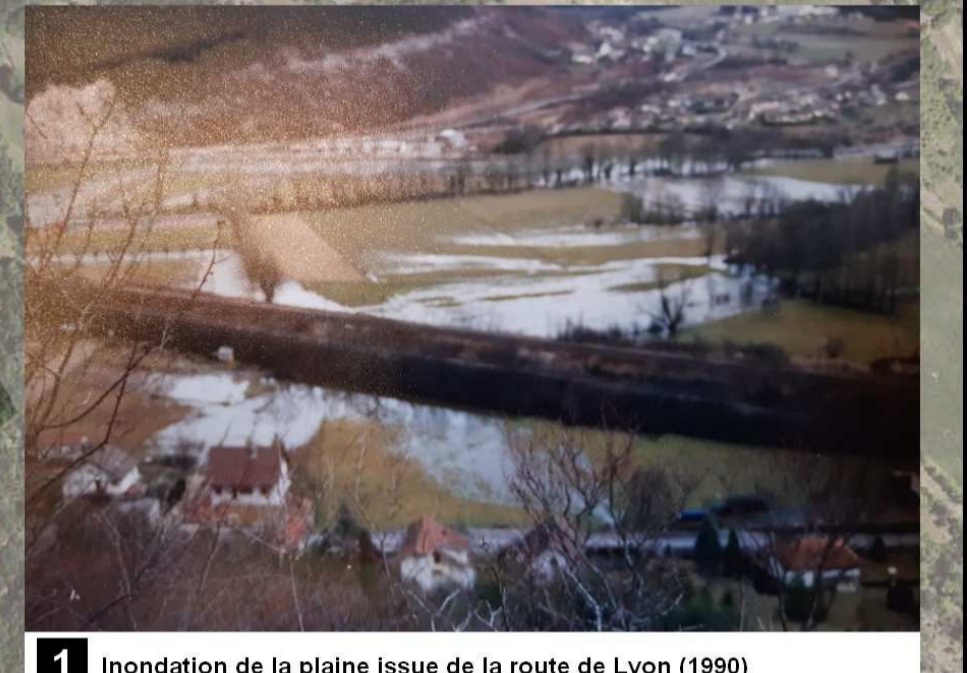
1 Inondation de la plaine issue de la route de Lyon (1990)
