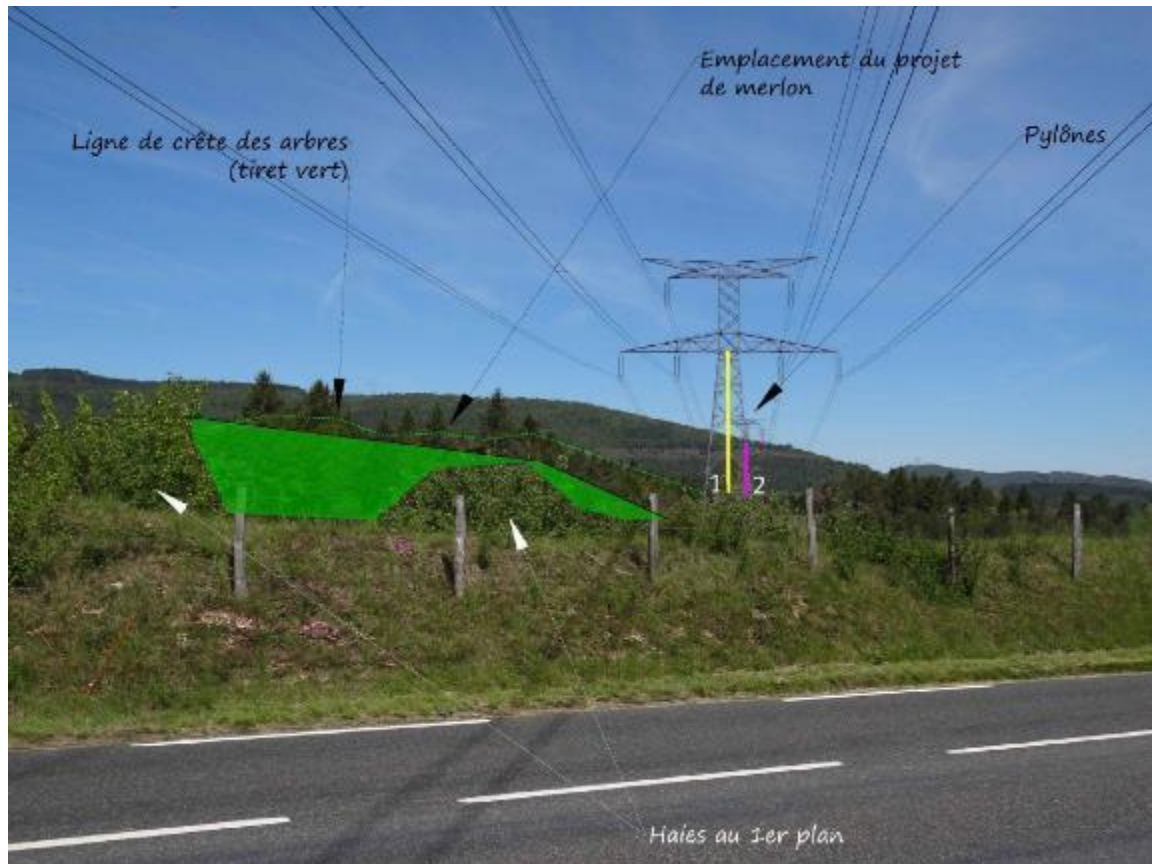
Figure 44 : Vue depuis la RD18 (route de l'ISDI)
