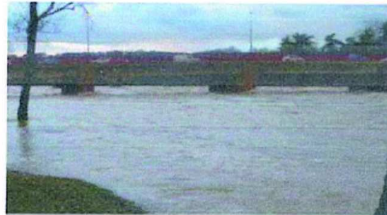
Observer la hauteur devant les piles
