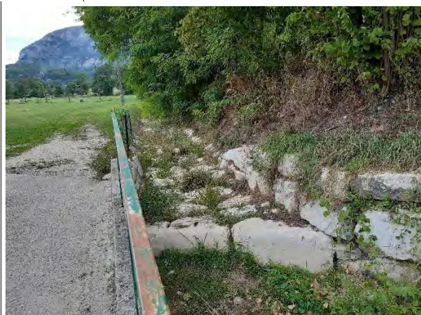
Bras de décharge aménagé en direction du stade
