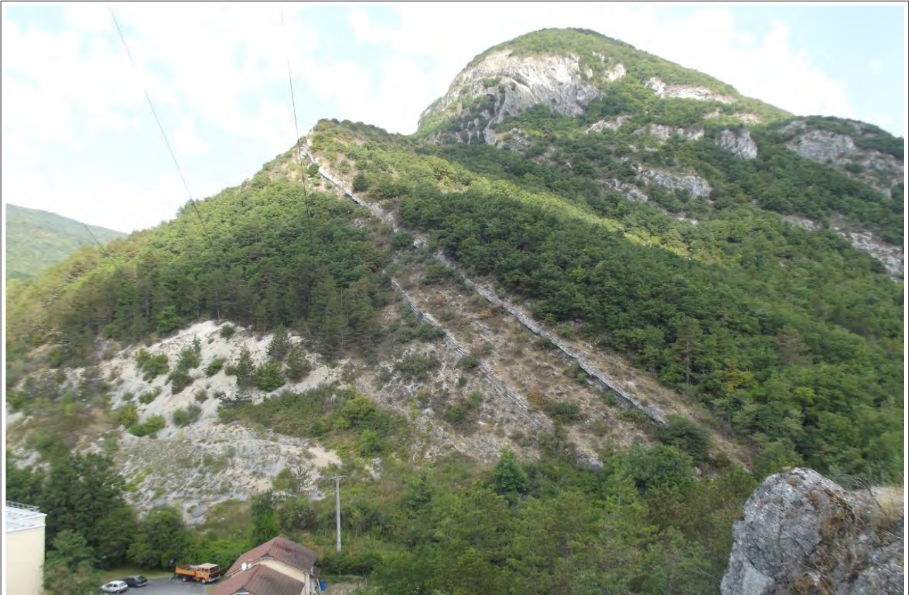
Rochers du Bétey: vue des zones de départ potentielles, du tablier d'éboulis et de la risberme en aval (photographie Alpes-Géo-Conseil 2020)
