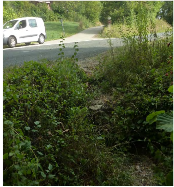
Fossé B, vue depuis l'aval
