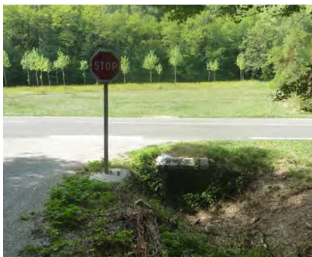
Ouvrage sous la RD904
