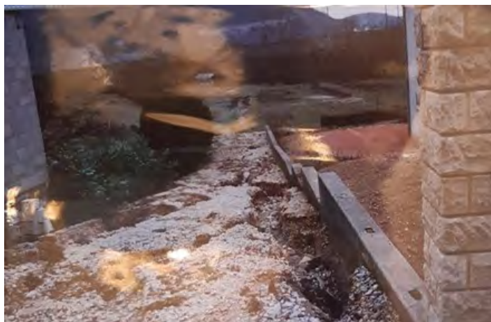
Parcelle le long de la route de Lyon après les inondations de 1990 (n°1)
