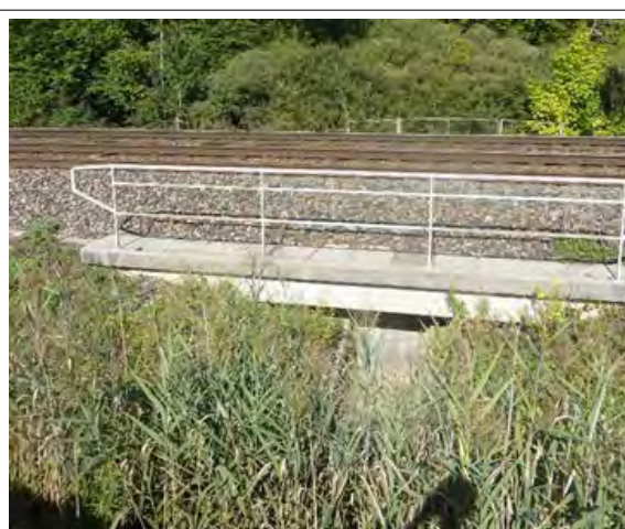
Unique ouvrage de rétablissement sous la voie ferrée
