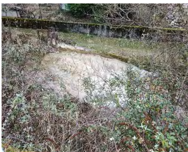
Seuil en amont du pont de la Couerie
