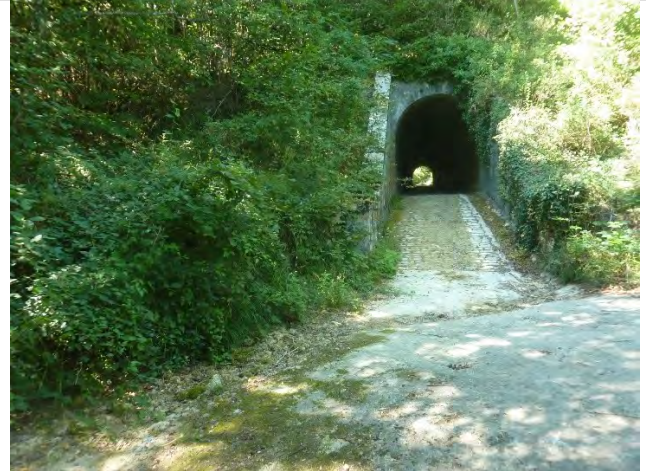
Vue aval du rétablissement
