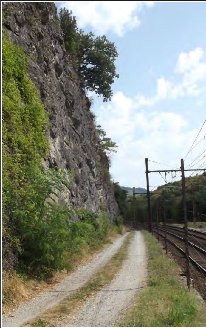
Ci-dessus : Vue Ouest A gauche : Est du massif photographies Alpes-Géo-Conseil 2020
