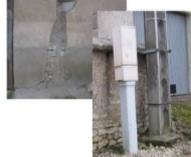
Arrimer et équiper d'une vanne les réservoirs à combustible
