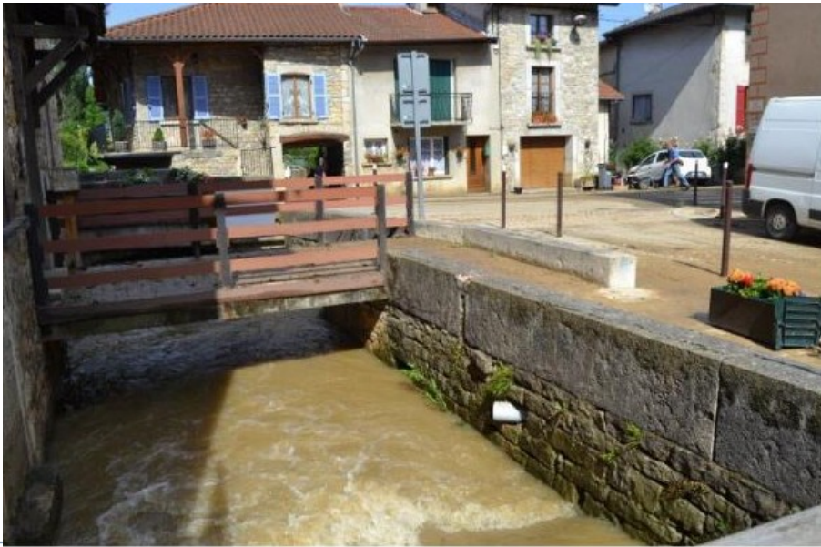
Les quais du Buizin qui a débordé en amont. Photo Progrès /Philippe BONNET
