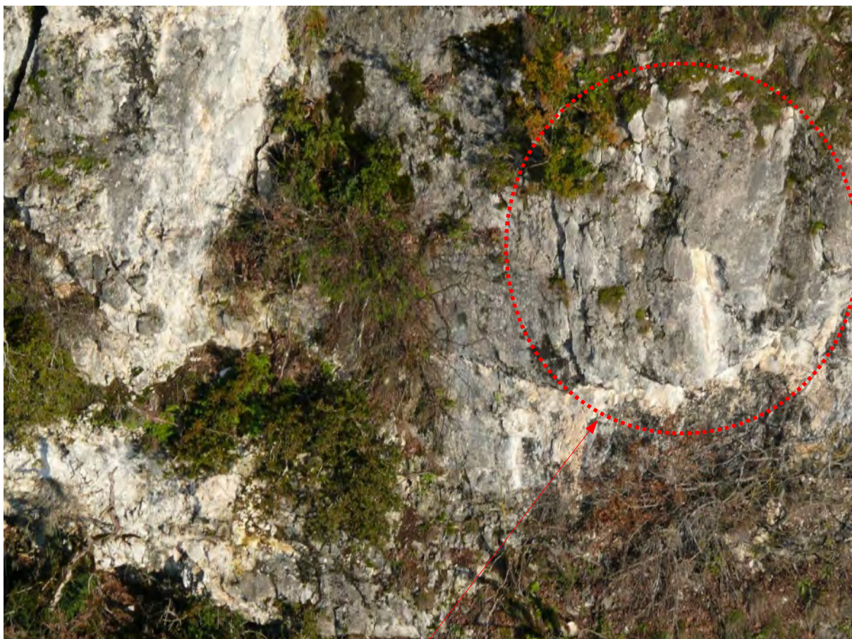
Exemple d'instabilité potentielle de classe masse (environ 15 m 3 ) Aléa d'éroulement individuel moyen à élevé
