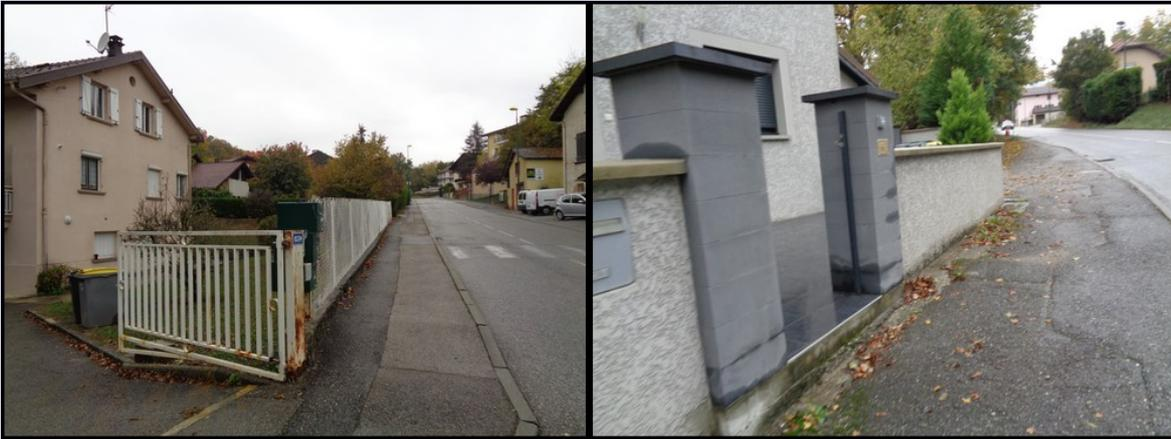
*Photos de murets limitant l'entrée des eaux de ruissellements dans le bâtiment*
