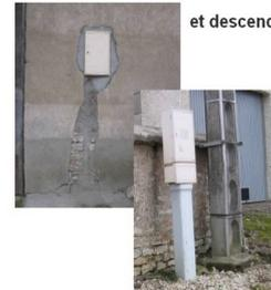
Placer les équipements électriques au-dessus du niveau des plus hautes eaux connues
