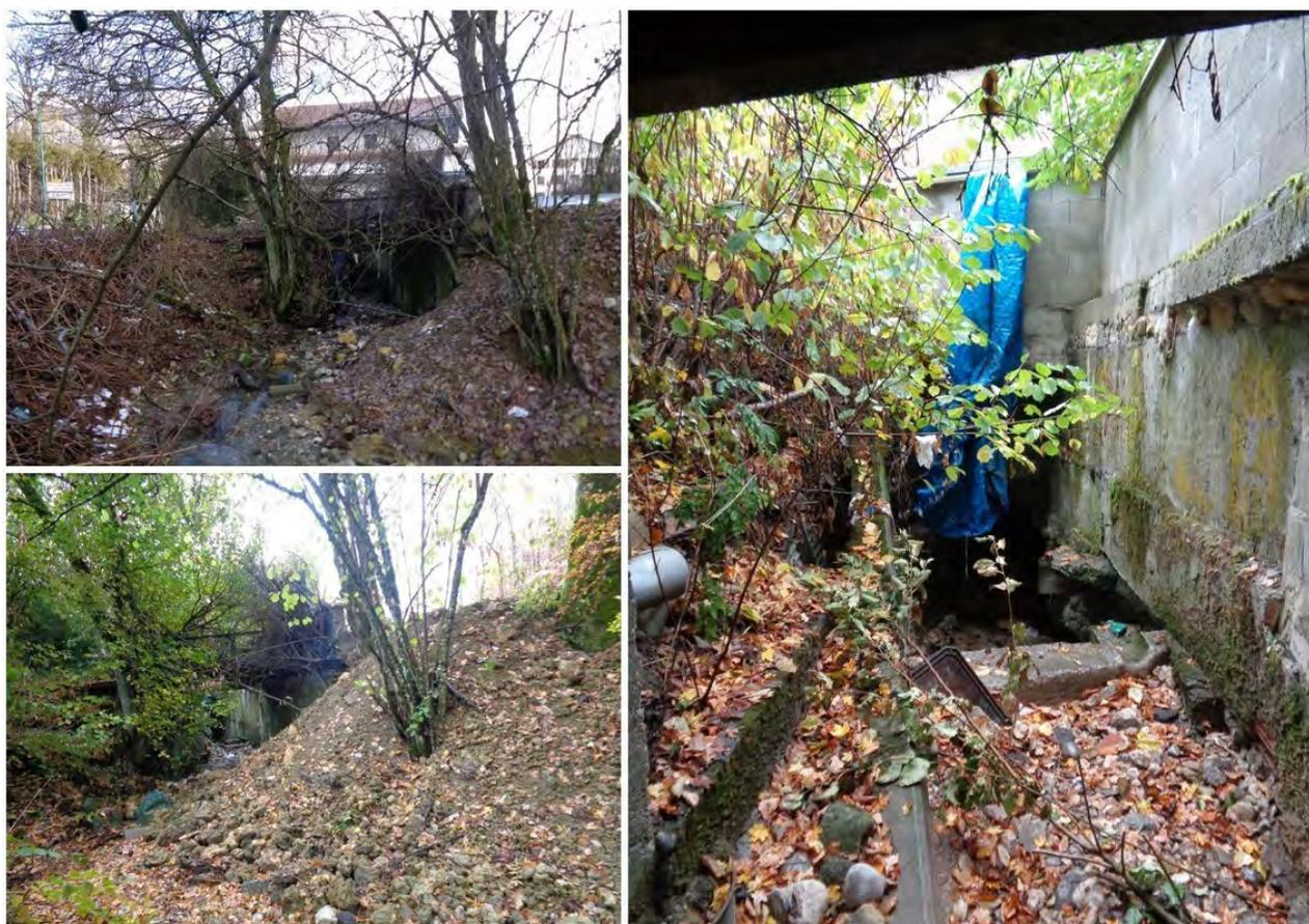
**Fig. 40** : Ruisseau des Lades canalisé sur environ 300 m sous les habitations et les terrains privés [Source : DDT]
