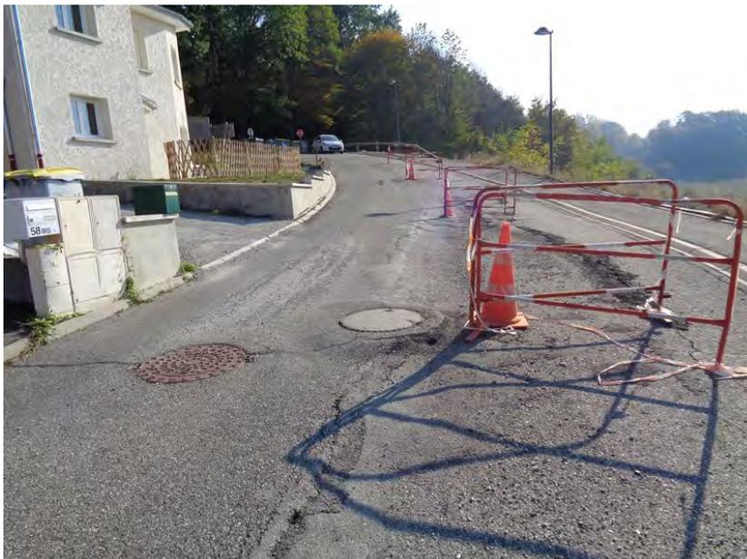
**Fig. 23 :** Fissuration, affaissement et décalage de la chaussée sur la voie d'accès au lotissement de Bellevue [Source : DDT01]
