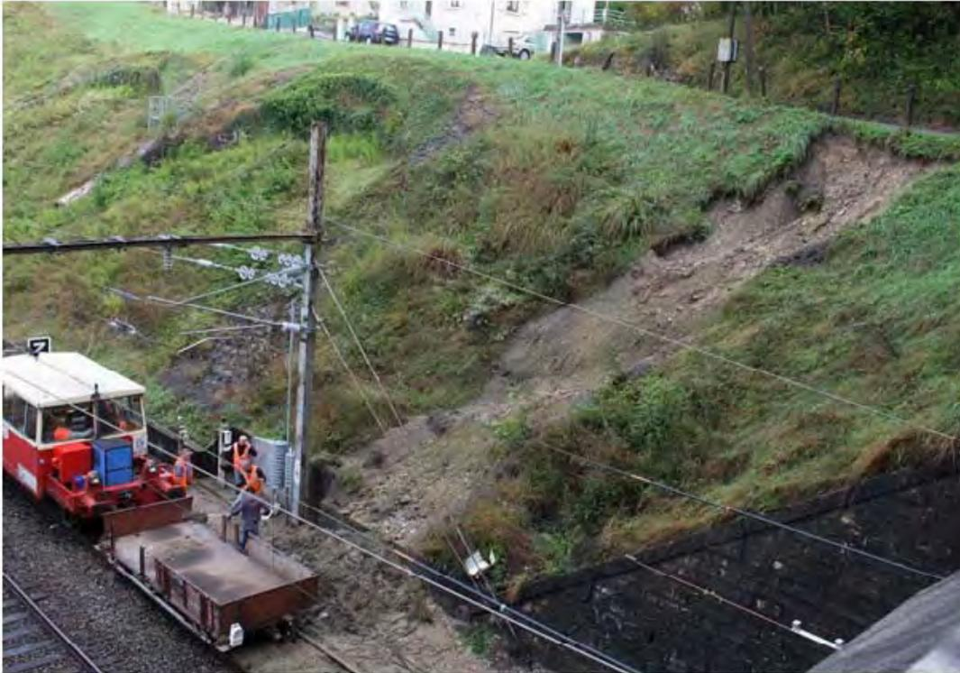
**Fig. 30** : Arches de confortement maçonnées (en haut à gauche de la photographie) le long de la voie ferrée Genève-Paris, à Coupy. A noter que le glissement du 07 au 08 novembre 2014 s'est produit là où le talus n'est pas conforté [Source : [www.ledauphine.com](http://www.ledauphine.com)]
