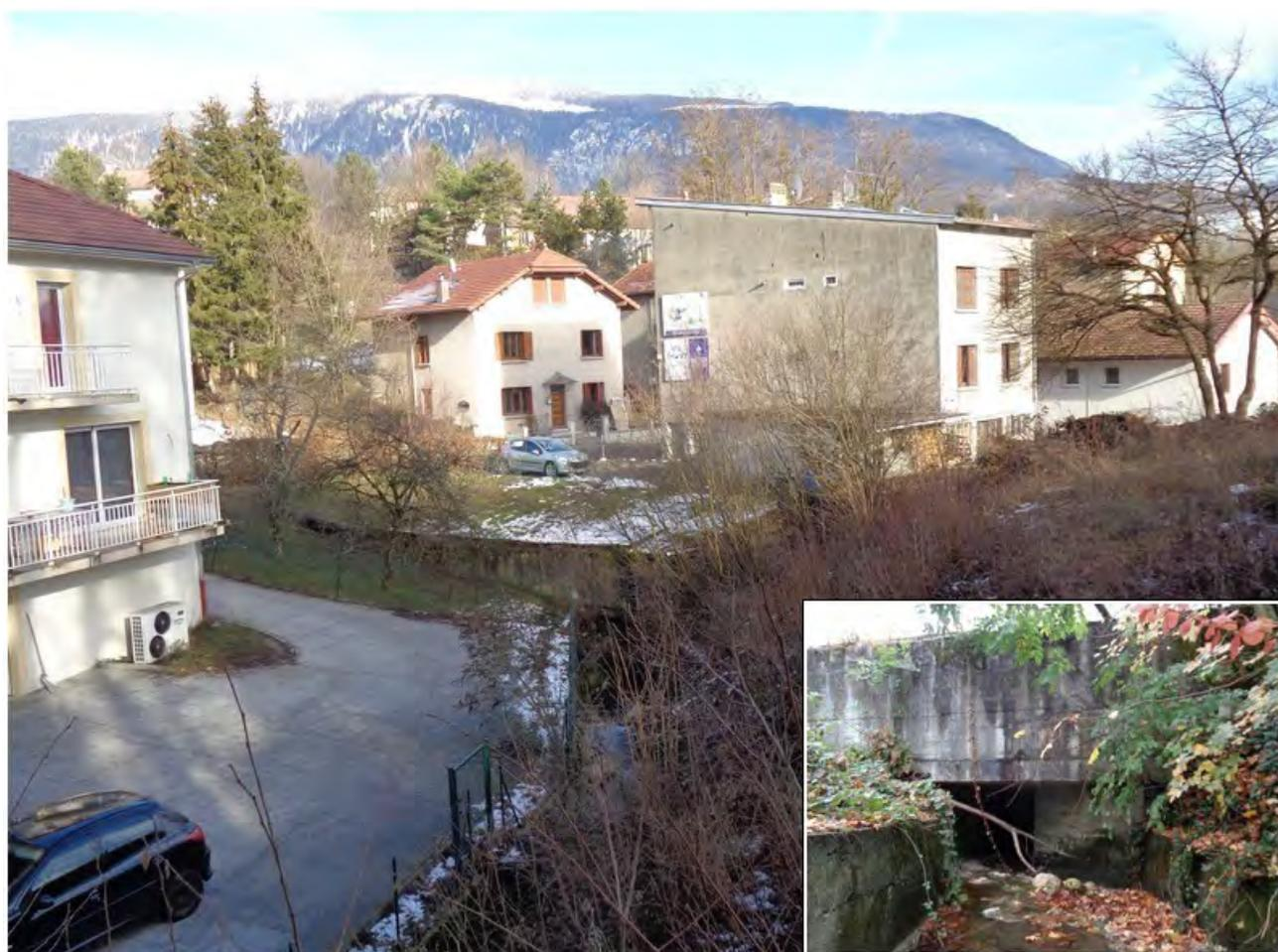
**Fig. 42** : Le ruisseau des Lades est canalisé sur environ 60 m sous les habitations et l'accès au lotissement « Le Quartier Manant » – En bas à droite entrée amont de la canalisation [Source : DDT]
