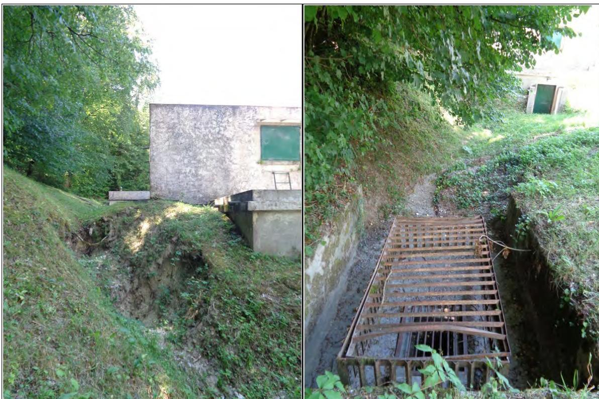
Fig 62 : Ravinement à proximité du réservoir de Mussel [Source : DDT01]
