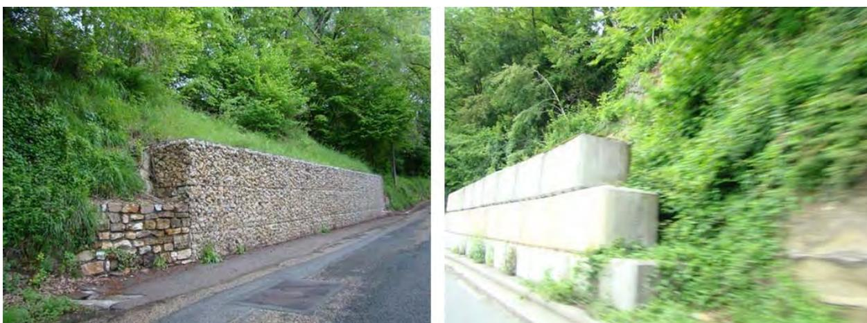
**Fig. 29** : Gabions le long de la RD 16, en amont de la Serme (à gauche) et mur de blocs bétonnés (mis en place suite au glissement du 20 janvier 2015) le long de la RD 1206, au niveau du ruisseau de Nambin (à droite) [ Source : IMS<sub>RN</sub> ]
