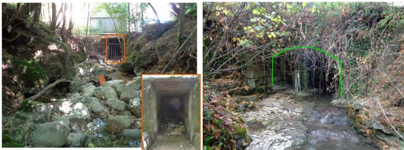
**Fig. 44** : Entrée amont du ruisseau sous le rond point des Lades (à gauche) et ouvrage cadre en sortie sur le Rhône au niveau du carrefour de Savoie – Longueur canalisée d'environ 500 m [Source : DDT]
