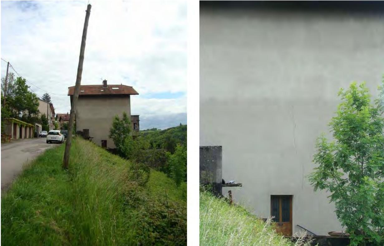
**Fig. 26 :** Poteau incliné, fissuration de la chaussée (au niveau de la voiture) et d'une construction le long de la RD16f (rue Hoche) à Coupy (à gauche) et détail de la fissure sur la construction (à droite) témoignant de l'instabilité du versant [ Source : IMS<sub>RN</sub> ]
