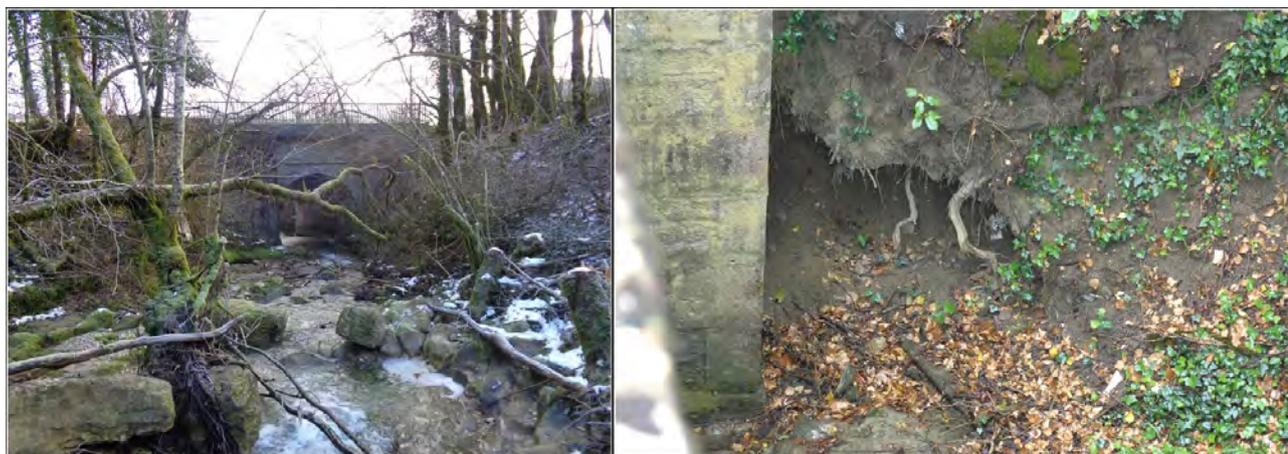
**Fig 64** : Érosion du lit de la rivière de la fontaine des malades au niveau de la pile du pont de la RD25
