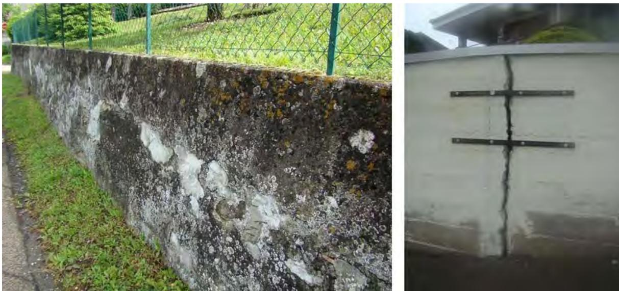
**Fig. 28** : Murs de soutènement bombé le long de la RD 16, à Vanchy (à gauche) et fissuré à l'angle de la rue du Ballon et de la rue des Écluses (à droite) sous l'effet de la poussée des terres (accrue sans doute par l'absence de drains en pied de mur) [ Source : IMS<sub>RN</sub> ]
