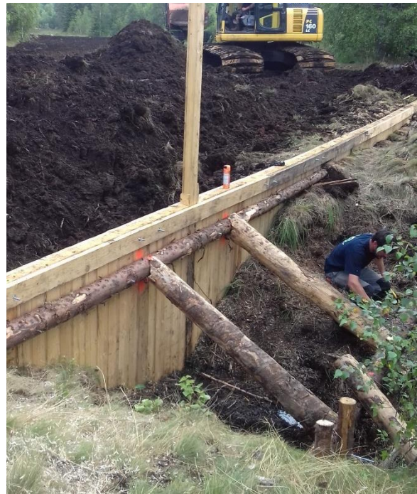
Finalisation de la palissade
