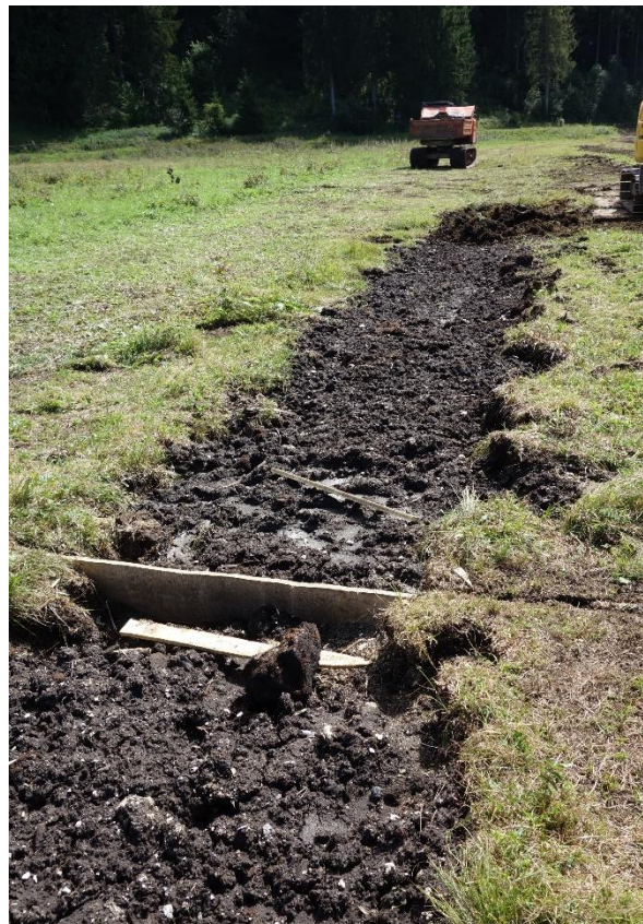
Figure 1 Les panneaux sont enfoncés au niveau du terrain naturel avant d'être recouverts de tourbe
