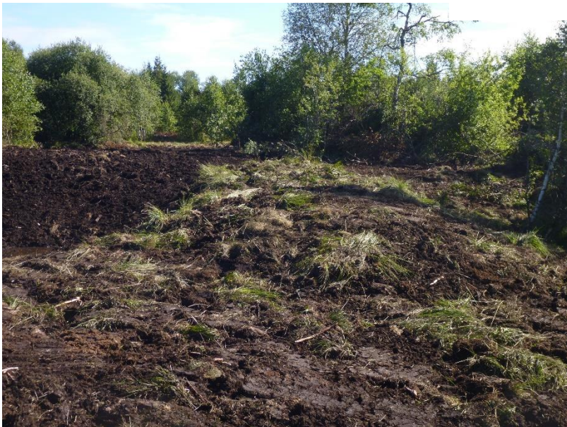
Une fois la palissade implantée, celle-ci est recouverte de tourbe qui sera revégétalisée
