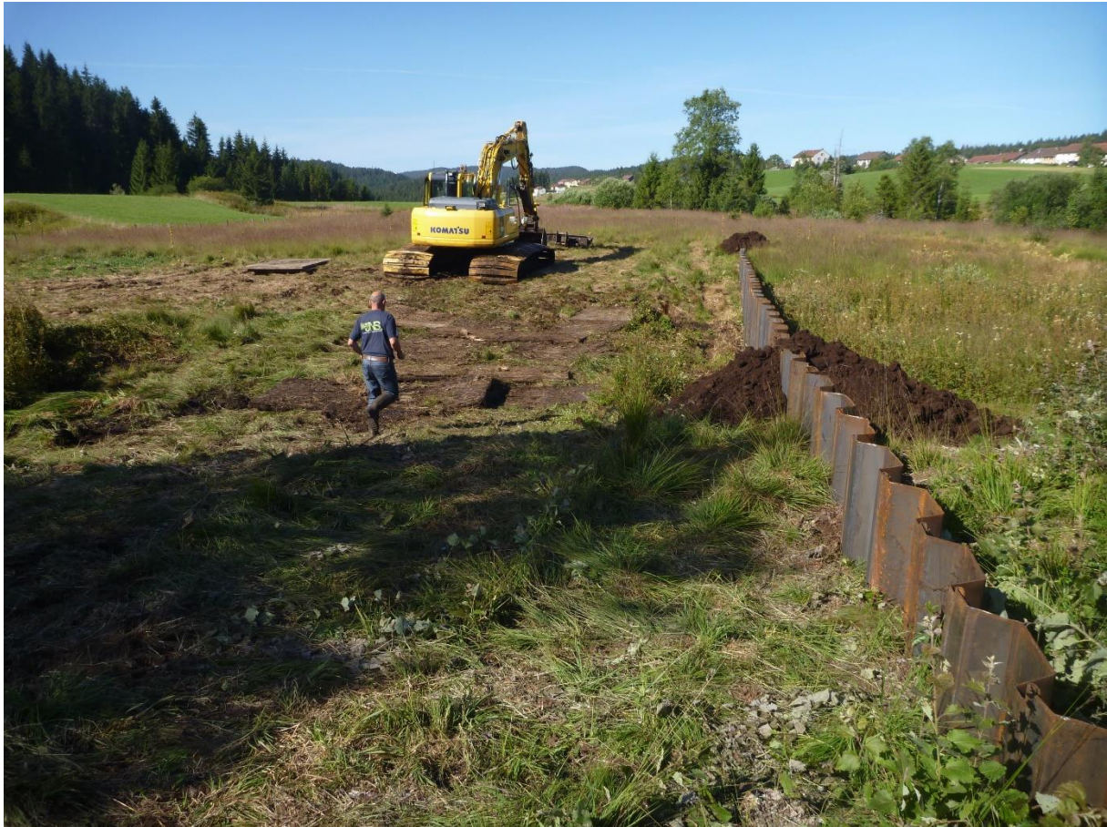
Dans des cas de forte pente ou de profondeur de tourbe trop importante, les madriers de bois sont remplacés par des palissades métalliques
