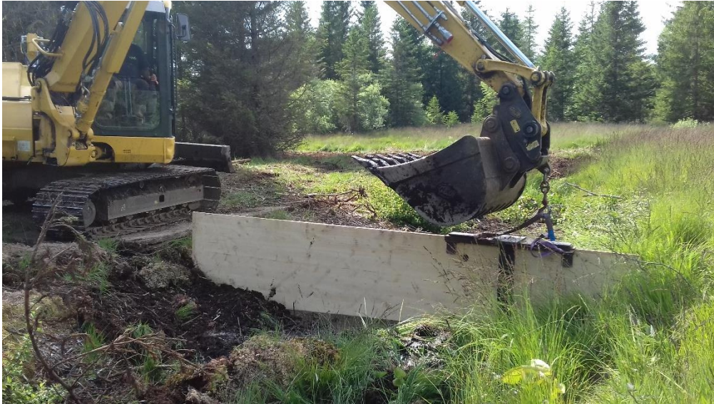
Implantation de panneaux pour le comblement d'un drain
