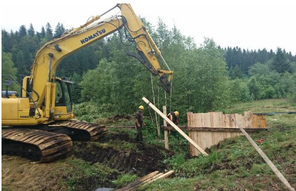
Implantation d'une palissade en madrier pour oblitérer une fosse de tourbage
