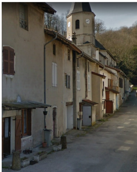
Bâtisses anciennes adjacentes à l'église (googlemap)
