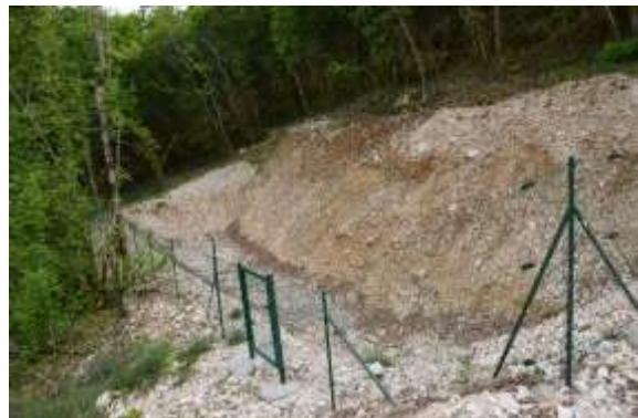
Bassin de rétention des eaux de ruissellement sur voie d'accès
