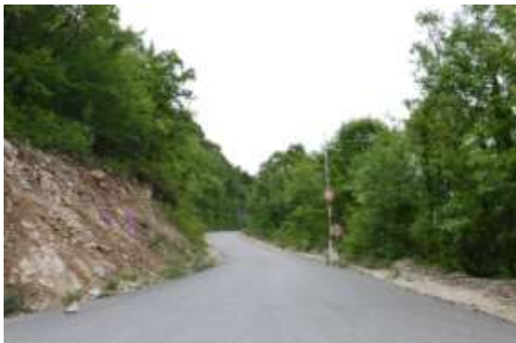
Barrière sur accès bas à la voie – voie enrobée
