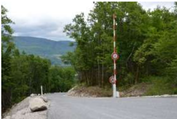
Barrière sur accès haut à la voie
