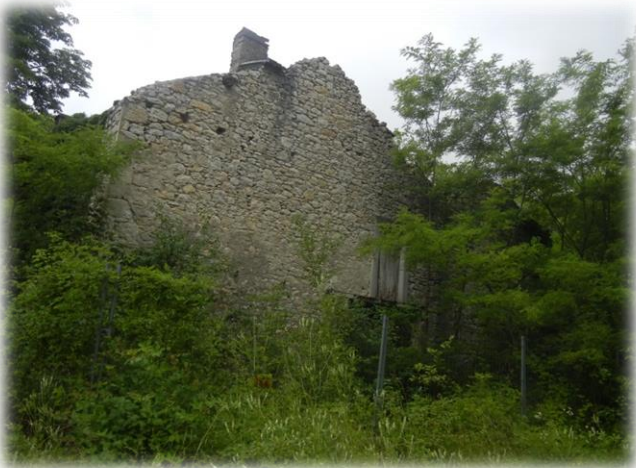
Ancien bâtiment, situé dans le périmètre éloigné. Gîte propice aux chiroptères.
