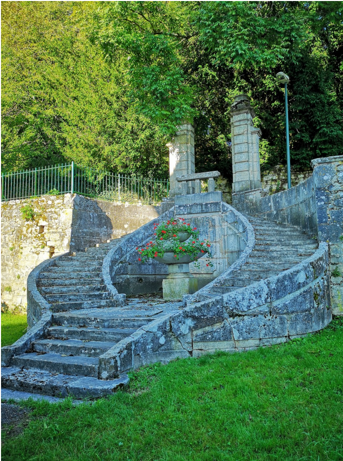
Escalier en fer à cheval de Varambon, photographie de 2021 (UDAP 01)
