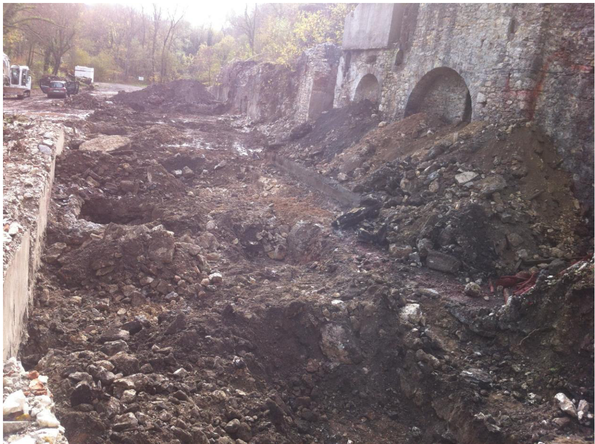
Mur de soutènement (à droite) après la déconstruction de l'usine (photo de 2013)
