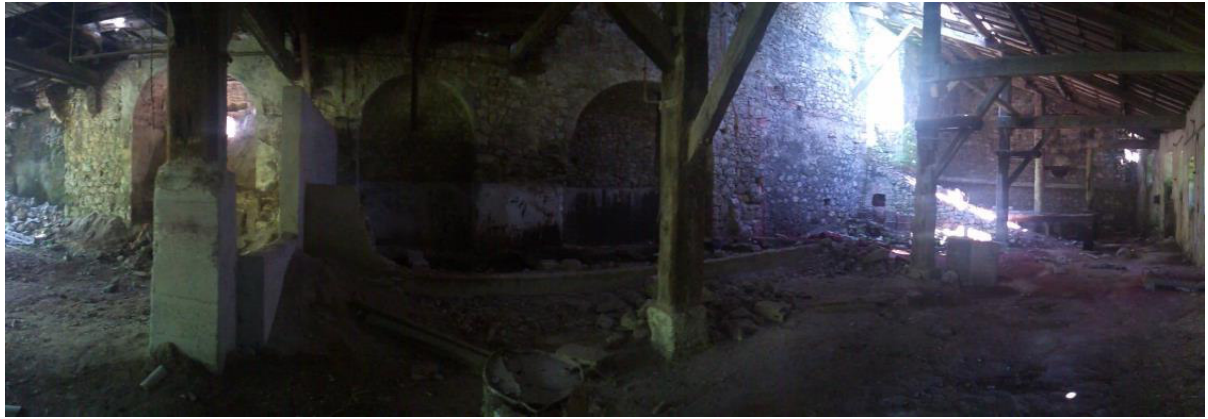
Mur de soutènement (au fond) avant la déconstruction de l'usine (photo de 2006)
