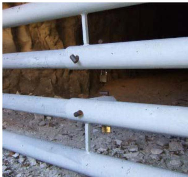
*Ci-dessus, système de double-clavettes sur deux barreaux coulissants.*
