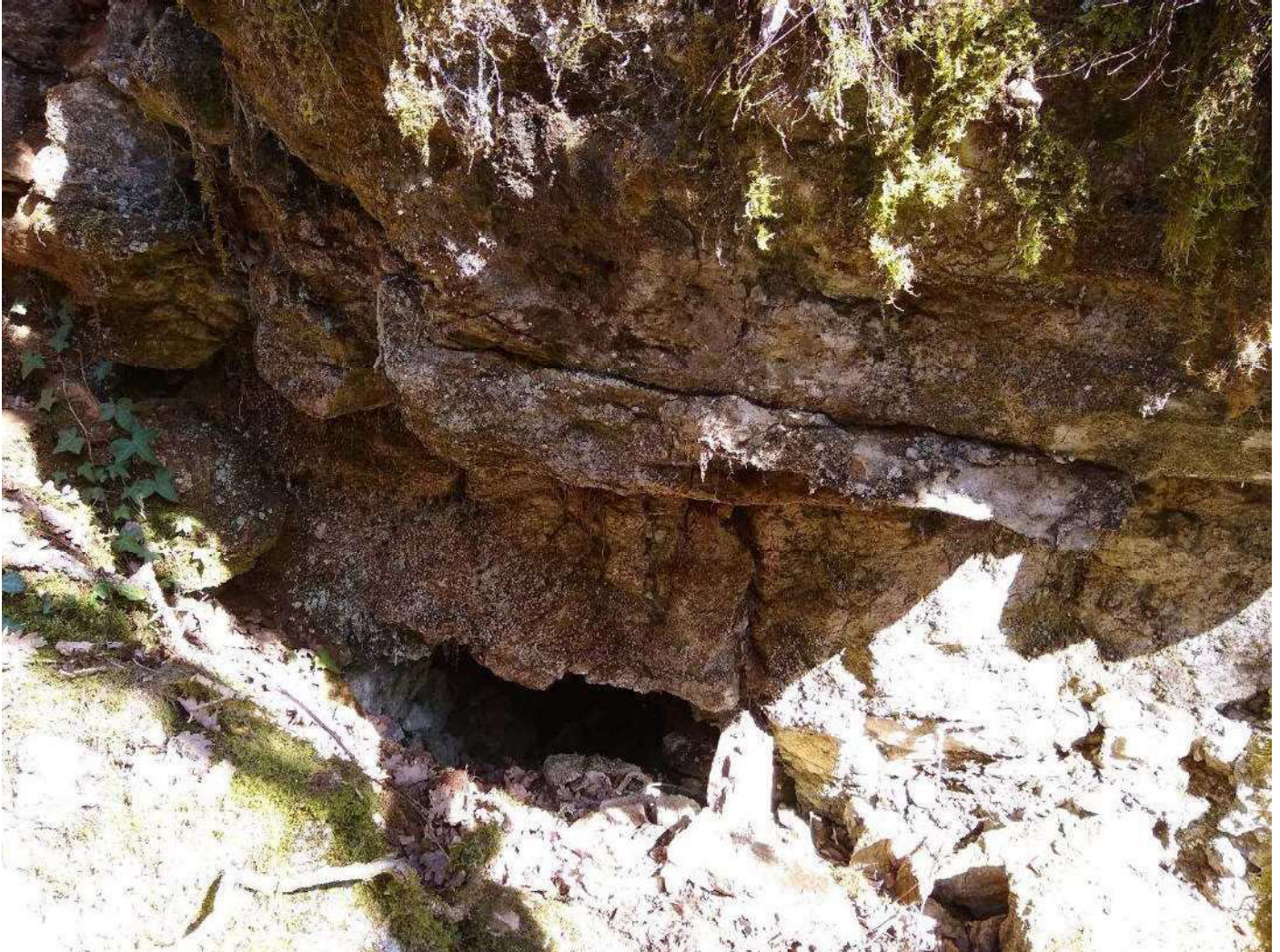
Orifice n° 15 – Photos du 30/03/2021
