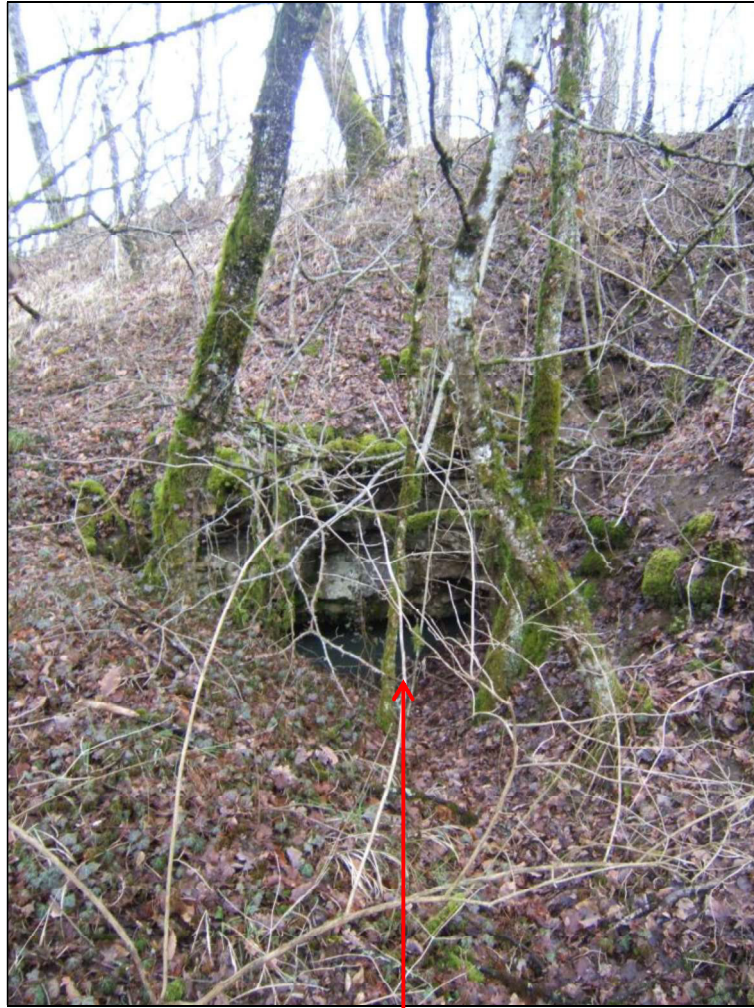
Orifice 18 – site 4 (Lades). Photo du 20 février 2006
