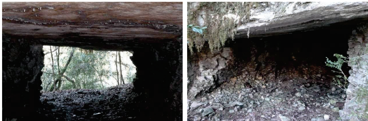
Entrée principale de la mine n°16.
