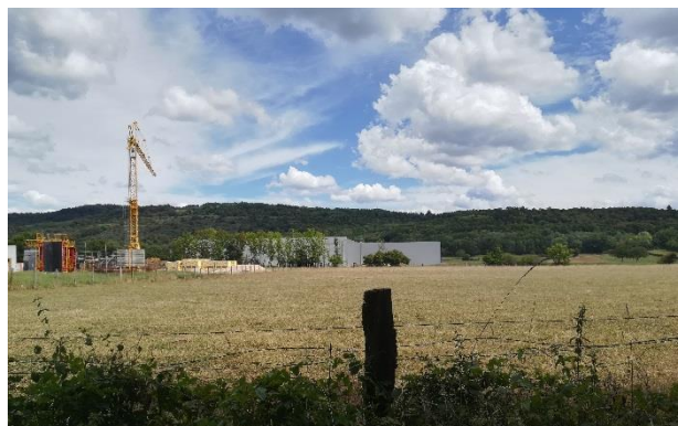
2 : Vue sur le bâtiment SDIS en construction et le bâtiment CAPS en arrière-plan
