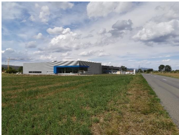
7 : Façade Sud de CAPS depuis la RD 42
