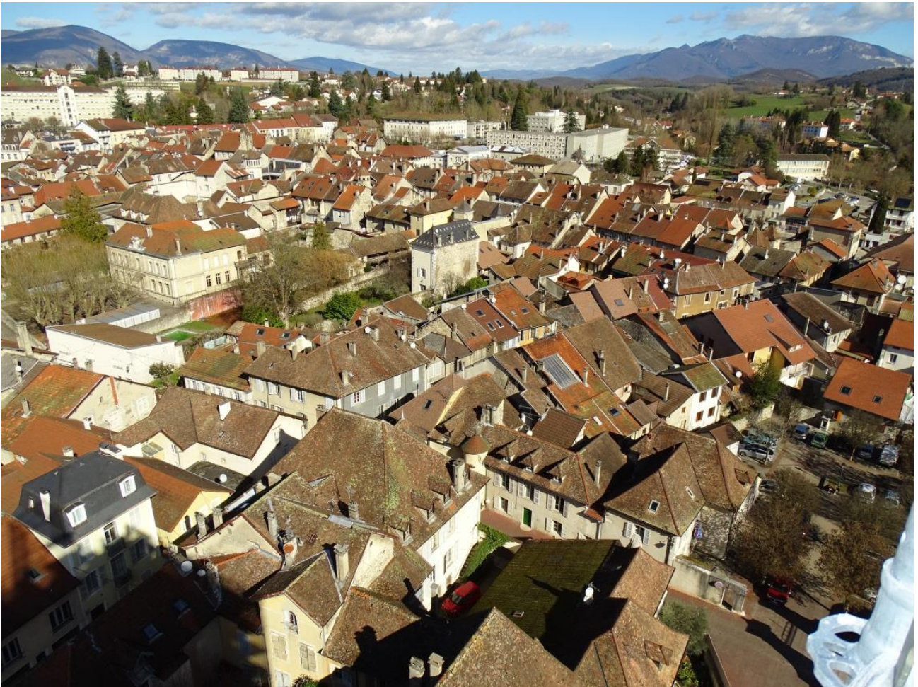
Toitures : 2 à 4 pans, l'égout du toit s'aligne sur la rue Couvertures : tuiles terre cuite, souvent écailles, rares toitures ardoises
