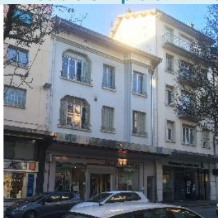
Immeuble de style «art déco» à lignes verticales fortes, travée en avancée, corniches à ressauts qui soulignent le couronnement en partie haute de la façade rue de la République-7_p201 -c1
