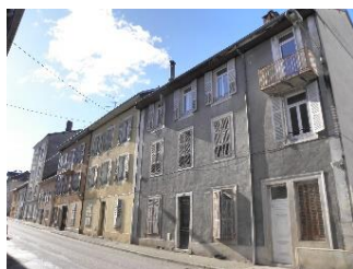
Immeubles simples XIXème: rez-de-chaussée + 2 étages ; volets bois persiennés, faitage parallèle à la rue, passée de toit rue de la République-50 à 64 - ens. homogène
