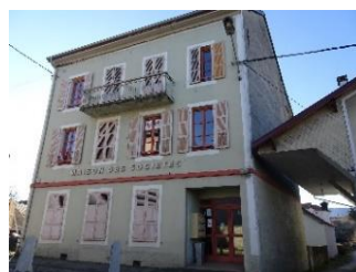
Immeuble simple début XXème: composition régulière des ouvertures avec hiérarchisation de leur dimension, balcon avec ferronnerie, passée de toit travaillée rue de la République-98_p167 -c2
