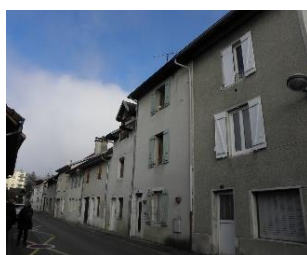
Maisons de faubourg fin XIXème : rez-de-chaussée, +1 ou 2 étages, faitage de la toiture parrallèle à la rue, porte et fenêtre jumelées Rue Ozereau-ens. Homogène
