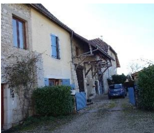
Ferme à bâtiments jointifs, enduit sur la partie logis avec avancée de toit sur les dépendances et structure du séchoir à bois Coron_p123 - c2
