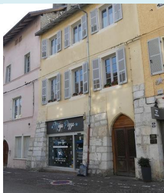
Composition de la façade XVIIème : régularité et hiérarchisation des ouvertures des étages, mais porche en ogive Présence de contreforts Grande rue-42_p439 -c2
