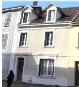
Maison de faubourg fin XIXème avec modénature : corniches, encadrement des ouvertures, et sousbassement souligné Rue Saint-Martin-88_p123 -c2 ens. homogène
