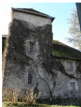
Domaine avec maison noble XVIème et dépendances : volume avec « tour », encadrement de fenêtre en pierre moulurée Coron_p9 - c1
