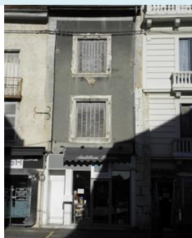
Demeure XVIème : façade étroite, fenêtres larges avec encadrement moulurés, disparition des meneaux centraux, linteau en accolade au 2 ème étage. Présence de contreforts Grande rue-19_p506 -c2
