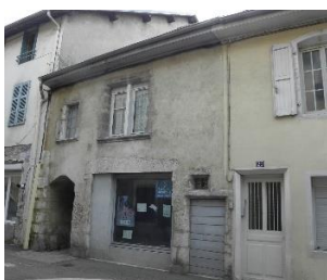
Demeure XVI ème ou XVIIème, passage vers Enclos Epsicopal A l'étage : fenêtre avec appui en pierre moulurée et ancienne fenêtre à meneau central Porte d'entrée en planches irrégulières; présence de contreforts rue Saint-Jean-25_p675 -c2
