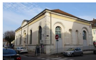
Les halles et l'ancienne grenette fermée.
