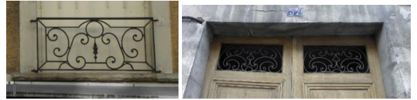
Ferronnerie en garde corps ou en imposte
