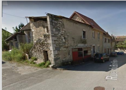
Rue Bon Repos avant réhabilitation
