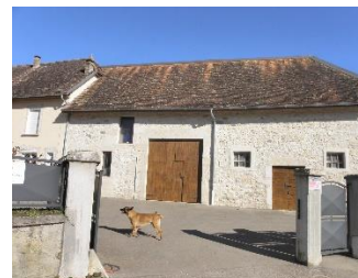
Ferme à bâtiments jointifs enduit sur la partie logis Portail de la grange à portillon central Bilignin_p158 - c2
