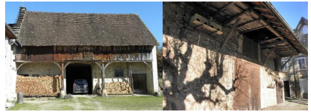
Billignin séchoir à bois, pignon à redents Coron : passée de toit sur grange
