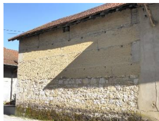
Grange en pisé avec soubassement en pierre Billignin_p156 -c2
