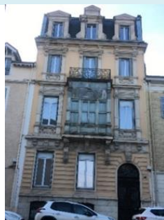
Immeuble bourgeois XIXème de style éclectique : modénature très marquée en ciment moulé, bow-window, balcons avec ferronneries, toitures à la Mansart avec lucarnes moulurées, porte d'entrée monumentale rue de la République-50_p133 -c1
