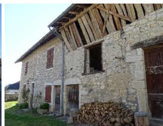
Ferme à bâtiment jointifs rejointement récent sur la partie logis, avancée de toit sur les dépendances et séchoir à bois, grange avec portillon central, calade en galet au droit de la grange Billignin_p108 -c2
