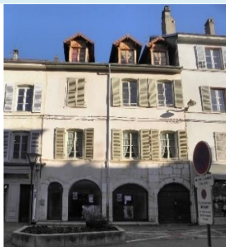
Demeure XVIème et XVIIème: façade large (regroupement de 2 parcelles) ; pierre de taille en soubassement avec arcades en plein-cintre et sur-baissée ou anse de panier, présence de contreforts Escalier intérieur en pierre rampe sur rampe Grande rue-7_p594 -c1
