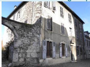
Maison bourgeoise XVIIIème avec jardin arrière et clôture en pierre. Escalier intérieur rampe sur rampe en pierre de taille avec ferronnerie Façade sur rue remaniée avec modénature XIXème rue Saint-Martin-26_p75 - c1
