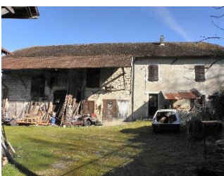
Ferme à bâtiment jointifs avec avancée de toit sur les dépendances, enduit sur la partie logis Coron_p69 - c2
