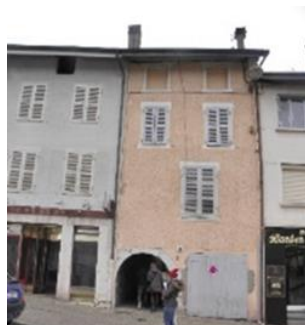
Façade lisse XVIème : arc en plein cintre, ouvertures non alignées (sur-elevation postérieure du dernier niveau) Grande rue-92_p80 - intéressant
