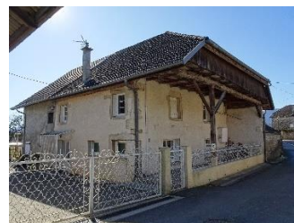
Ferme ramassée à bâtiments jointifs avec avancée de toit très importante et séchoir à bois Billignin_p66 - intéressants
