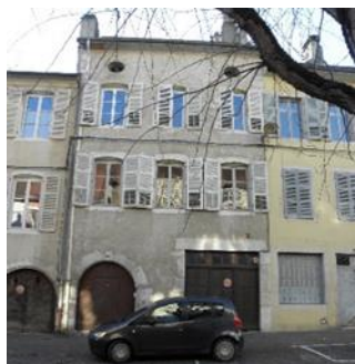
Composition de la façade XVIIème avec hiérarchisation des ouvertures des étages, mais porche en plein cintre en rez-de-chaussée Jardin/cour avec galerie bois Grande rue-60_p443 -c1
