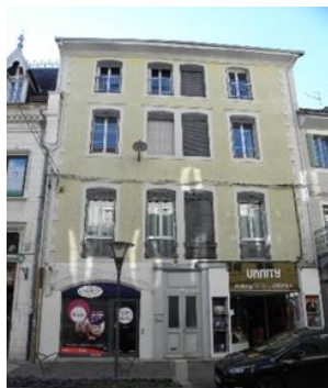
Composition de la façade XVIIème avec hiérarchisation des ouvertures, arc surbaissé avec pierres chanfreinées en rez de chaussée mais traitement du décors XIXème avec lambrequin et ferronnerie de qualité, passée de toit travaillée avec moulure Grande rue-32_p428 -c2
