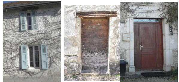
Fenêtre bois avec partition du vitrage, et différents modèles de porte en bois pour les logis, selon leur époque et le statut
