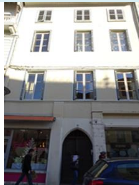
Demeure XVI et XVIIème: Composition régulière et hiérarchisation des fenêtres des étages. Ouverture du rez de chaussée avec arcs en ogive et pierres chanfreinées. Porte d'entrée à panneaux moulurés et imposte ajourée Présence de contreforts Cour avec coursive ouverte et dépendances Grande rue-23_p504 -c1
