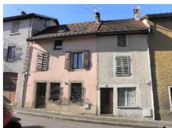
Maisons de faubourg XIXème : rez-de-chaussée, +1 ou 2 étages, faitage de la toiture parrallèle à la rue porte et fenêtre jumelées rue de la République -120-122_p216-217 ens. homogène 112 à 126
