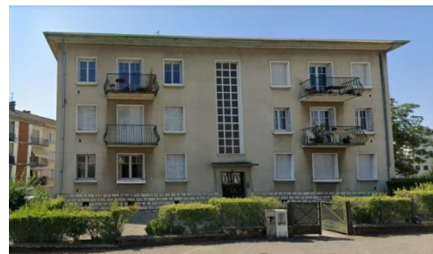
Avenue Brillat Savarin : composition classique des ouvertures traitement du soubassement avec plaquage de pierre, axe de symétrie marqué par l'entrée et la verticalité de l'ouverture unique qui éclaire les escaliers communs.
