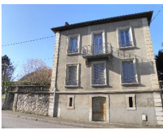
Maison bourgeoise fin XIXème début XXème, construite en alignement sur la rue avec jardin attenant et clôture. Modénature en ciment moulé rue de la République -132_p352 -c1
