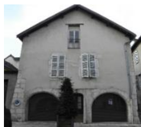
Bâtiment XVIème avec linteau en accolade sur la rue des cordeliers, façade à pignon sur la rue Saint Jean avec arcade sur en anse de panier , soubassement en pierre de taille et contrefort. rue Saint-Jean-38_p340 -c1
