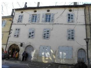
Demeure XVIème, XVIIème et XVIIIème siècle : large façade, (regroupement possible de 2 parcelles), présence de contreforts, ouvertures du rez de chaussée en plein cintre avec monogramme sculpté Alignement des ouvertures sur la partie la plus récente. Porte cochère avec Vantaux bois à planches et portillon central. Escalier intérieur avec serrurerie XVIIIème Grande rue-64_p692 -c1
