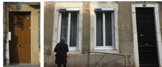
Dénaturation : porte de style « anglo-saxon » ; Menuiserie pvc avec coffret de volet roulant apparent
