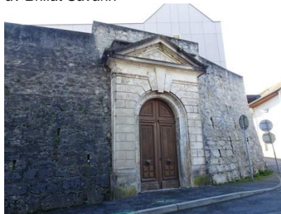
Ancien couvent Bon Repos, rue de Savoie
