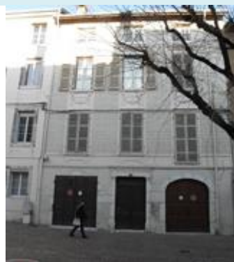
Demeure avec façade XVIII ème, début XIXème, de composition symétrique, avec hiérarchisation des ouvertures, modénatures avec bas relief et faux appareillage, soubassement en pierre de taille avec arc surbaissé ou linteau plat mouluré pour l'entrée (l'ouverture de gauche était également en arc surbaissé) Porte d'entrée avec vantaux bois à panneaux moulurés et imposte ajourée en fer forgé Grande rue-47_p806 -c1
