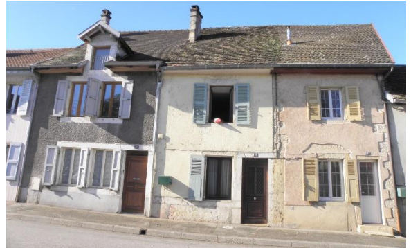
Maison de faubourg : ouvertures jumelées en rez de chaussée : porte+ fenêtre ou 2 fenêtres, facade enduite et pierre de taille en encadrement
