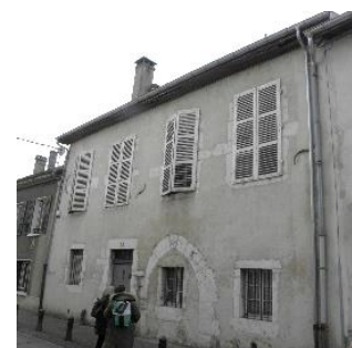
Façade XVème ou XVIème remaniée avec arc brisé et percement irrégulier des fenêtre en rez de chaussée (bâtiment appartenant au couvent des Cordeliers) rue des Cordeliers-24_p343 -c1
