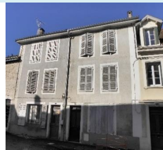
Maison de faubourg XIXème : bâtiments jumelés, composition régulière des ouvertures des 2 étages Rue Saint-Martin-90- 92_p124 -c2 ens. homogène
