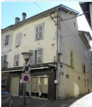
Demeure XVIème et XVIIème Fenêtre à traverse sur rue des Cordeliers Façade de composition régulière sur Grande rue, corniche en pierre moulurée (cordon) et chaîne d'angle en pierre de taille avec niche pour sculpture Grande rue-4_p392 -c1
