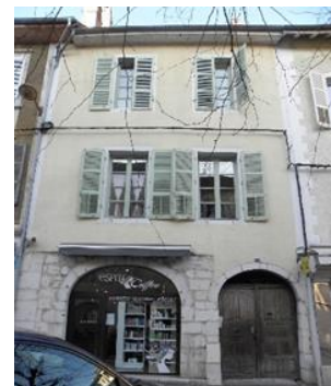
Demeure XVIIème: soubassement en pierre de taille, arcades en anse de panier, porte à panneaux avec imposte en fer forgé, cour intérieur avec coursive bois et porte moulurée XVIème. Grande rue-39_p496 -c1
