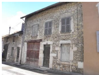
Ferme en milieu urbain avec logis sur rue attenant aux dépendances, portail de grange avec portillon central et porte d'entrée à panneau avec imposte vitrée rue Sainte-Marie-29_p22 - c2
