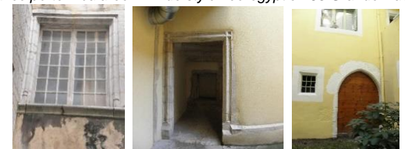
Menuiserie XVIII°, porte d'entrée depuis les cours : 11, 42 ; 58 Grande rue
