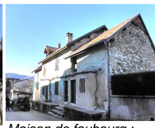
Maison de faubourg : rez-de-chaussée + 1 étage, faitage de la toiture parrallèle à la rue, porte et fenêtre jumelées rue Bon Repos-15_p183 ens. homogène rue du Mont et rue de Bon Repos
