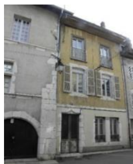
Composition XVIIème de la façade avec soubassement marqué mais linteau médiéval du porche d'entrée. rue Saint-Jean-45_p122 -c2
