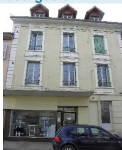
Immeuble bourgeois XIXème : soubassement et modénature marquée en ciment moulé : corniches, chaînes d'angle, encadrement des ouvertures rue de la République-26_p119 -c2
