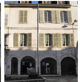
Maison de bourg simple: façade enduite, pierre de taille uniquement pour les encadrements des portes ou contreforts
