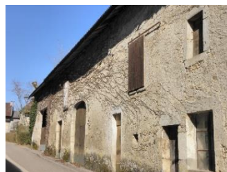
Ferme sur rue avec logis attenant aux dépendances, granges et étables (ou écuries), arc en pierre surbaissé, vantaux de la porte de la grange avec portillon central et arc surbaissé en pierre Billignin_p 60 -c2
