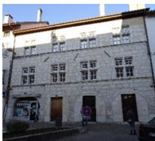
Demeure XVIème ou XVIIème: façade en pierre de taille Reconstitution des croisées en 1982 Bandeau en pierre Garde-corps en fer forgé XVIIIème Cour avec escalier à vis Grande rue-33_p626 -c1
