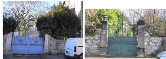
Portail métallique plein en partie basse et ajouré en partie haute
