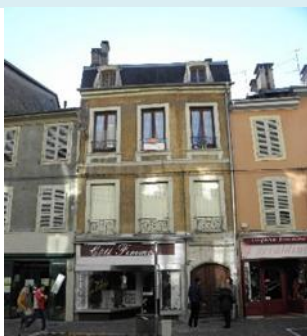
Demeure fin XVIIème début XVIIIème : porche d'entrée en arc surbaissé et vantaux à panneaux en pointe de diamant, corniche et encadrements moulurés, ferronneries XVIIIème Grande rue-12_p395 -c1
