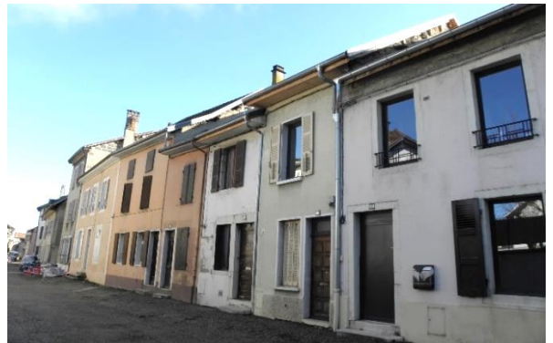
Rue Saint Martin : faible hauteur des bâtiments et front bâti homogène
