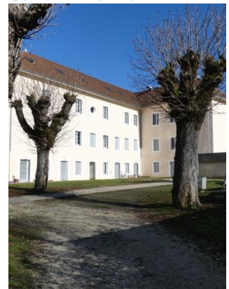
Rue du Chapitre_p620 Clos Chapitre
