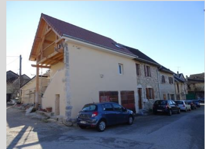
Rue Bon Repos après réhabilitation
