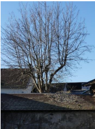
Rue des Barons_p615 Couvent des Cordeliers Coron
