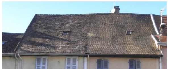
Rue Saint Jean : tuile écaïlle de teinte sombre, ouverture réduite à quelques fenêtres de toit de petite dimension
