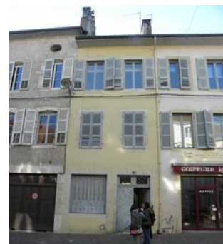
Demeure XVIème et XVIIIème siècle : composition de la façade XVIIème avec ouvertures régulières. Large fenêtre anciennement jumelée en rez-de-chaussée Cour XVIème avec escalier-hors œuvre à vis, et galerie maçonnée ou en bois rue Saint-Jean-58_p442 -c1
