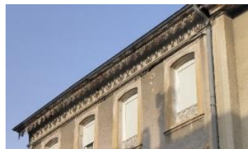
Rue G. Girerd : lambrequin bois au bas de la toiture
