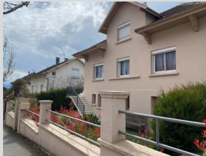
Rue de la Louvatière
