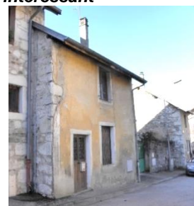
Maison de faubourg : rez-de-chaussée + 1 étage, faitage de la toiture parrallèle à la rue, enduit avec modénature peinte rue du Mont-34_p6 ens. homogène rue du Mont et rue de Bon Repos
