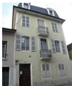
Immeuble bourgeois XIXème : composition hiérarchisée, encadrements peints, présence de balcons en pierre avec ferronnerie, toiture à la Mansard avec lucarne, porte d'entrée à imposte rue Saint-Jean-44_p336 -c1
