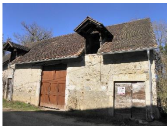
Dépendance dissociée avec portail de la grange à portillon central Fenière en toiture et profondeur importante de la passée de toit Bilignin_p123 -c2
