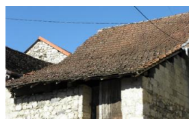
Billignin : tuile mécanique avec coyau
