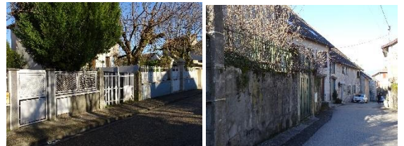
Mur bahut surmonté de grille ajourée et de végétation
