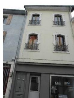
Façade avec composition XVIIème :fenêtres alignées, encadrement et ferronnerie XIXème, soubassement différencié, Grande rue -116_p580 -c2
