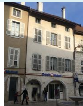
Demeure XVIIème : Composition régulière et hiérarchisation des fenêtres des étages. Ouvertures du rez-de- chaussée avec arc en anse de panier et pierres moulurées Grande rue-31_p 626-c2
