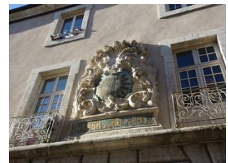
Ancien hôtel de ville, rue Lamartine. Façade sur rue et toiture inscrites le 13 avril 1944.
