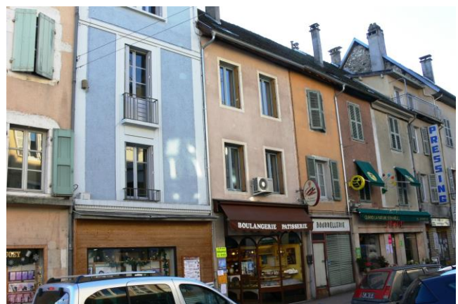
Opération façades, source SOLIHA Ain
