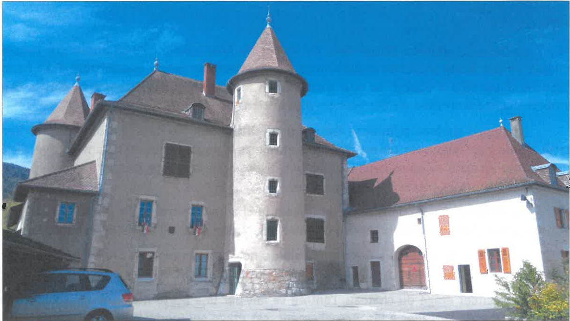
Château de Vesancy, façade Sud-Est, 2018 (source : UDAP 01)
