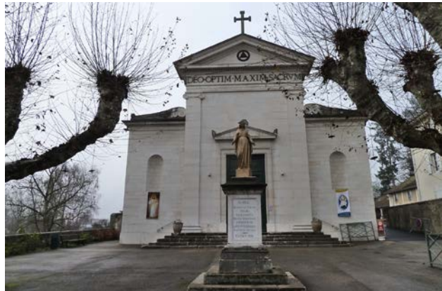
2. Perspective sur la façade principale de l'église depuis l'avenue du bijou)
