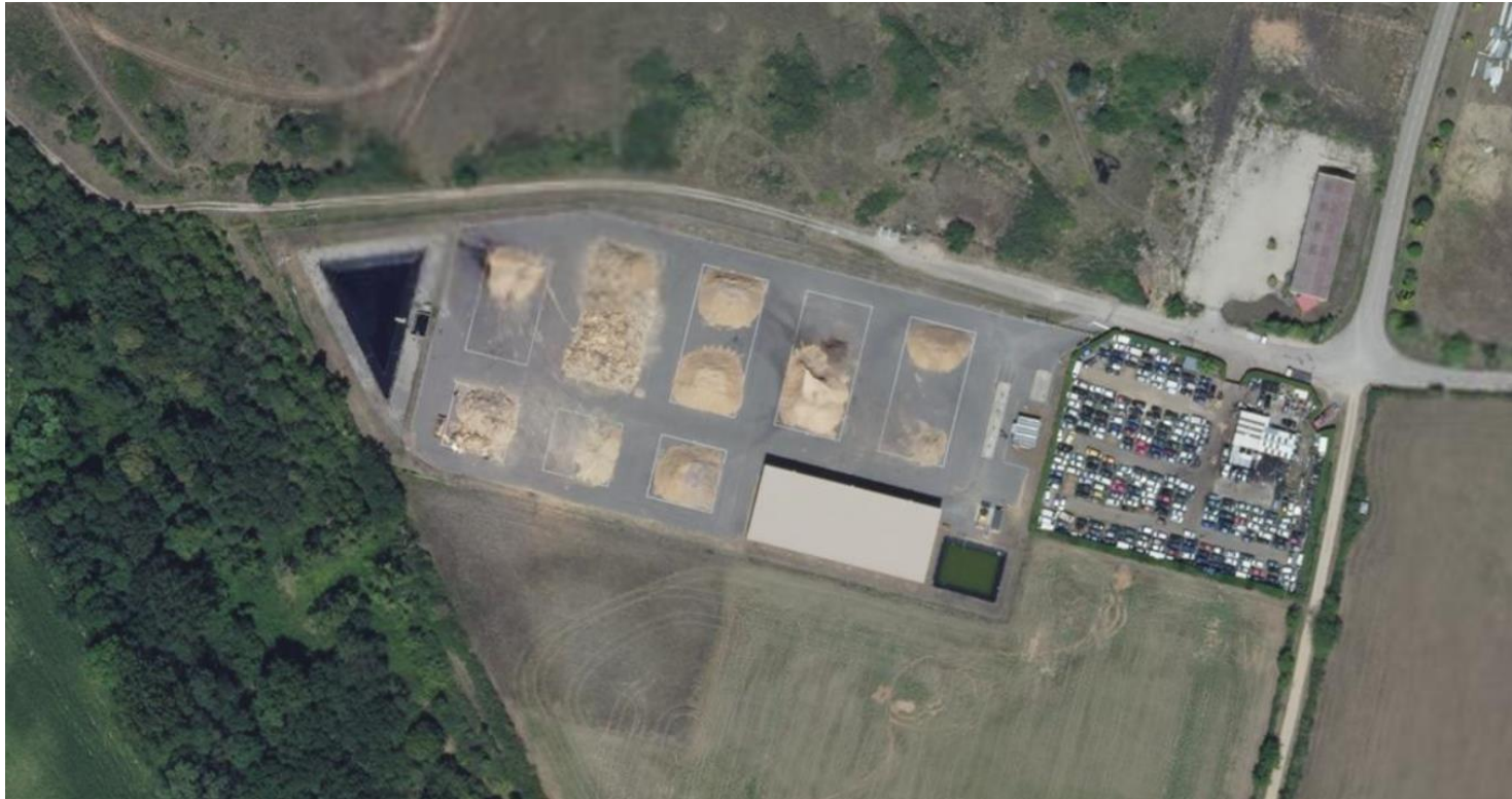
Photo aérienne – juillet 2018
